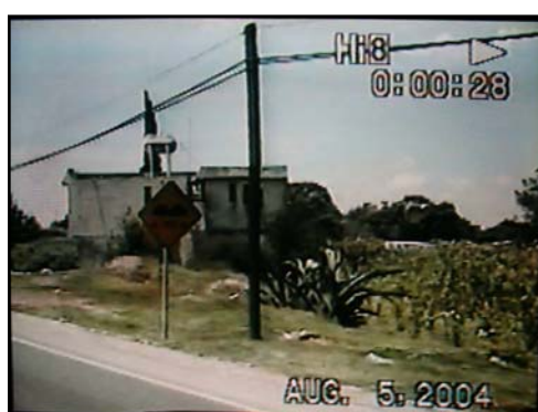
Fig. 42 y 43 Áreas de transición a lo largo de la vía corta. Fotografías del Autor.
