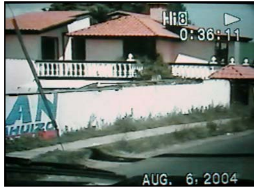
Fig. 59 y 60 Tipologías arquitectónicas a lo largo de las vías secundarias. Fotos: Orlando Isaac Ipiña García
