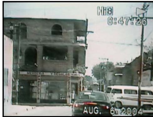
Fig. 57 y 58 Trazas irregulares con mala señalización y recorridos confusos. Fotos: Orlando Isaac Ipiña García
