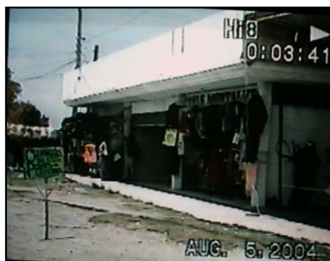
Fig. 40 y 41 Estado de las construcciones a lo largo de la vía corta.
