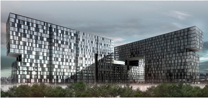
Ilustración 7. Centro comercial y torre corporativa Samara.
