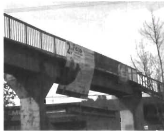
Lonas en puente peatonal
