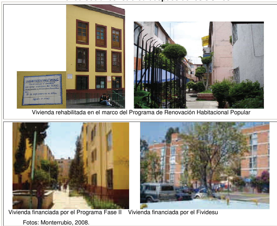
Foto 2.6 Vivienda social construida después de los sismos
