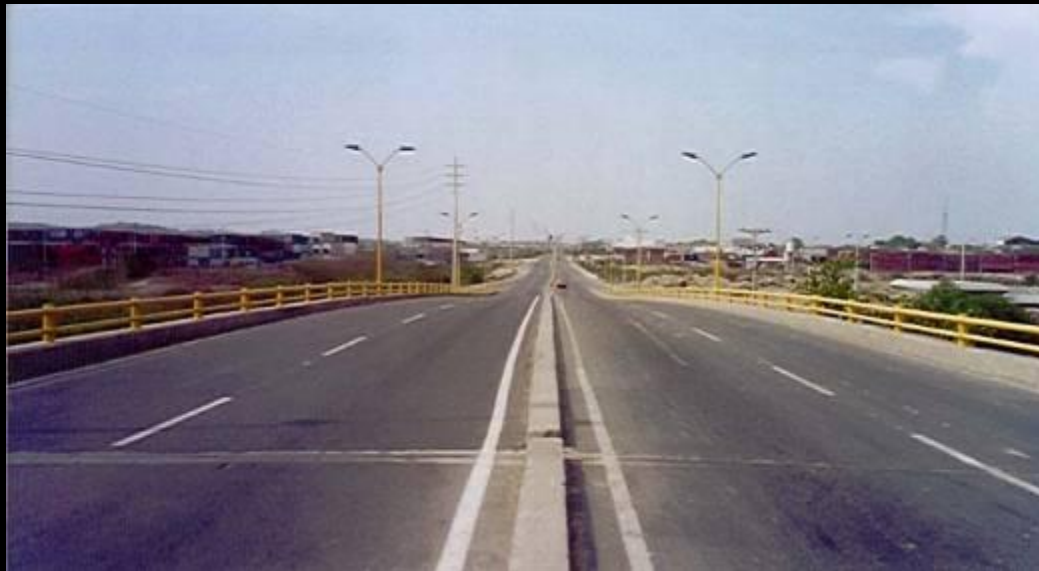
Nuevo Corredor de Carga
