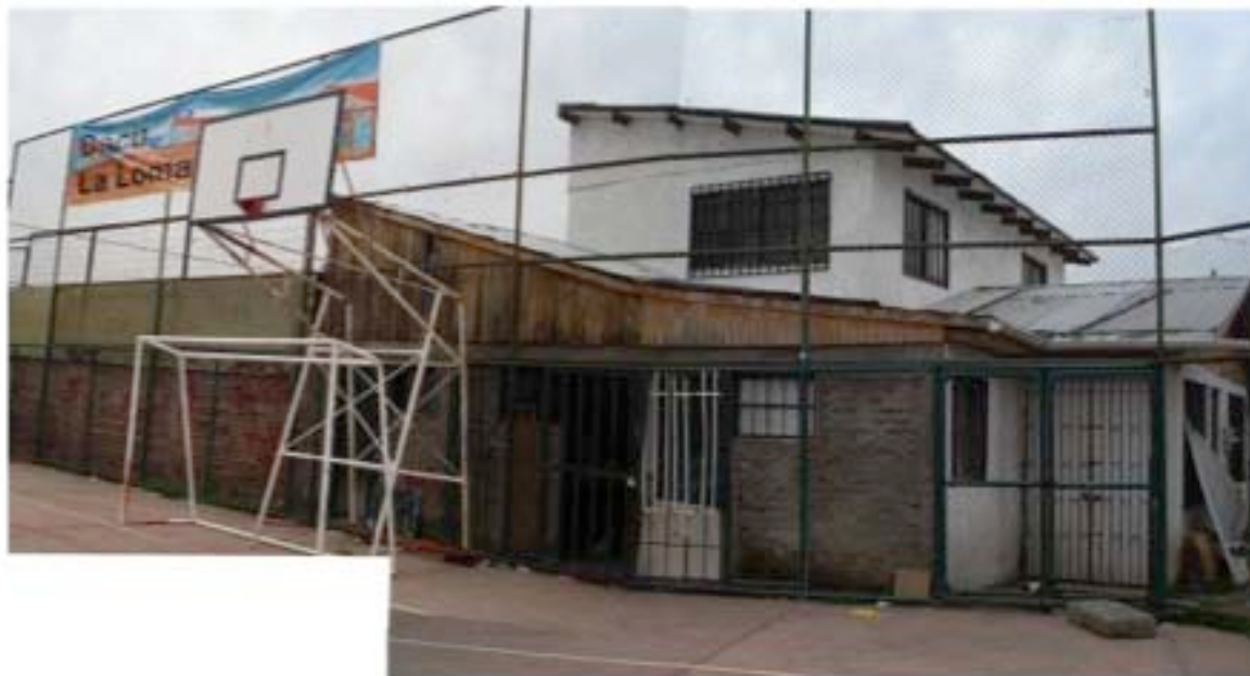
■ CENTRO COMUNITARIO (ASOCIADO A LA MULTICANCHA)
