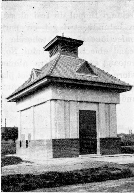
Casă de transformator, tip scund.
