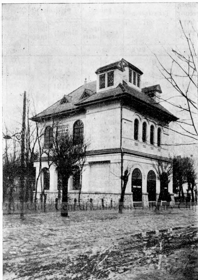
Substațiunea de transformare, Piața Asanești, 1926.
