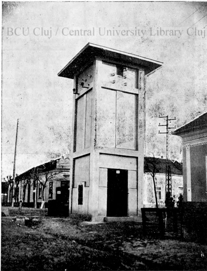
Casă de transformator, tip turn.
