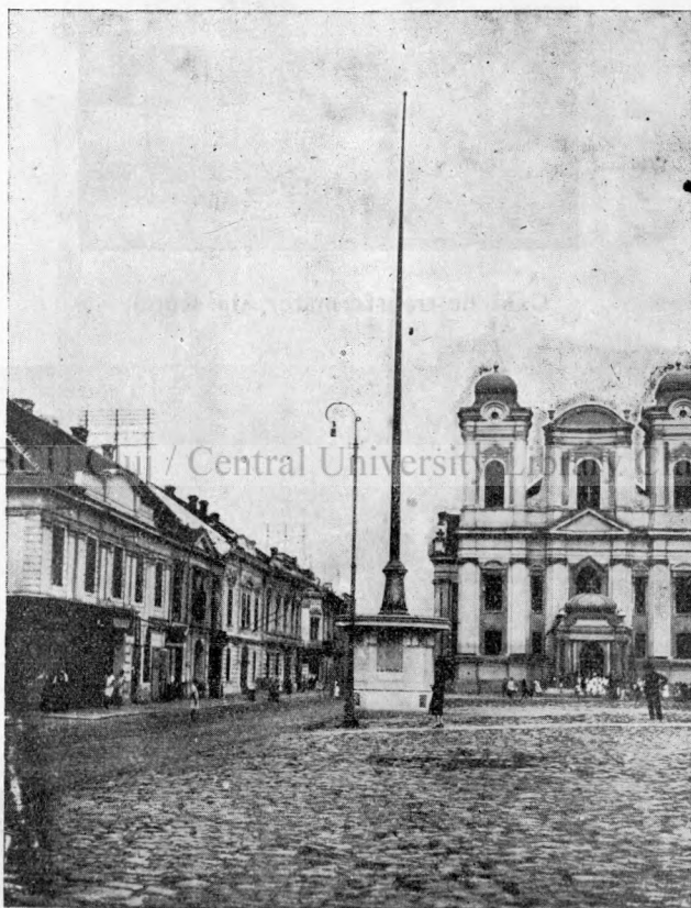
Casa de transformator din Piața Unirei.
