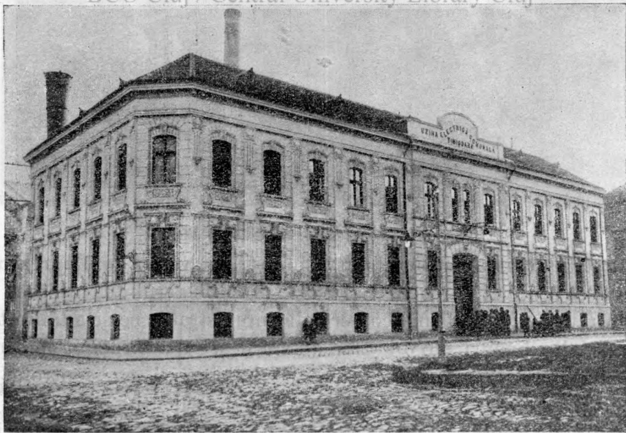
Edificiul administrativ al Uzinei, 1900.
