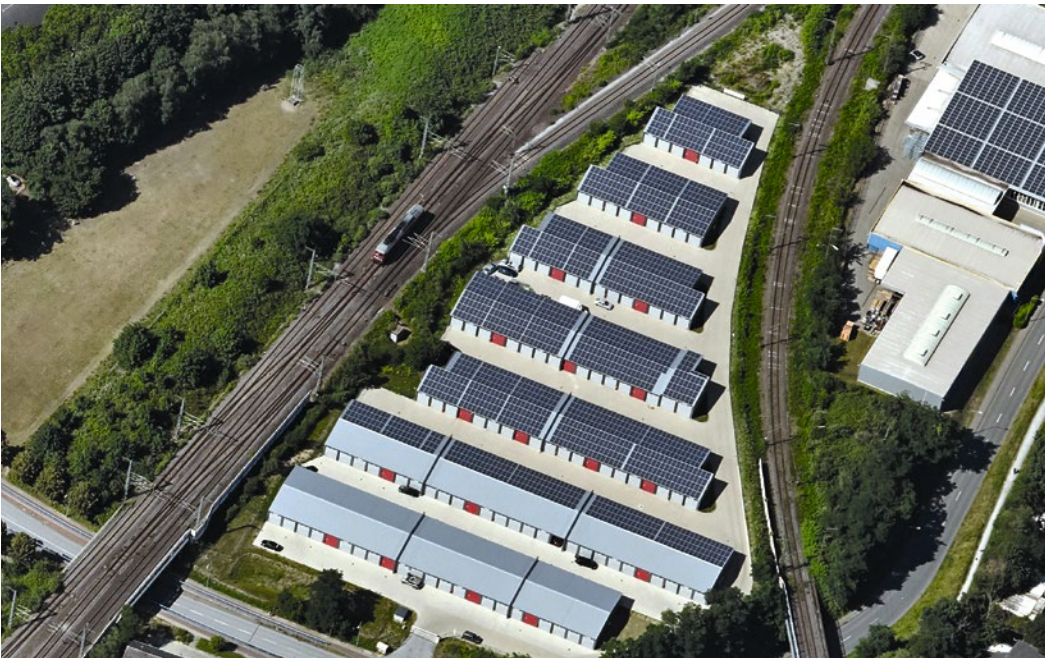
Solardächer Gohrweide, Bottrop
