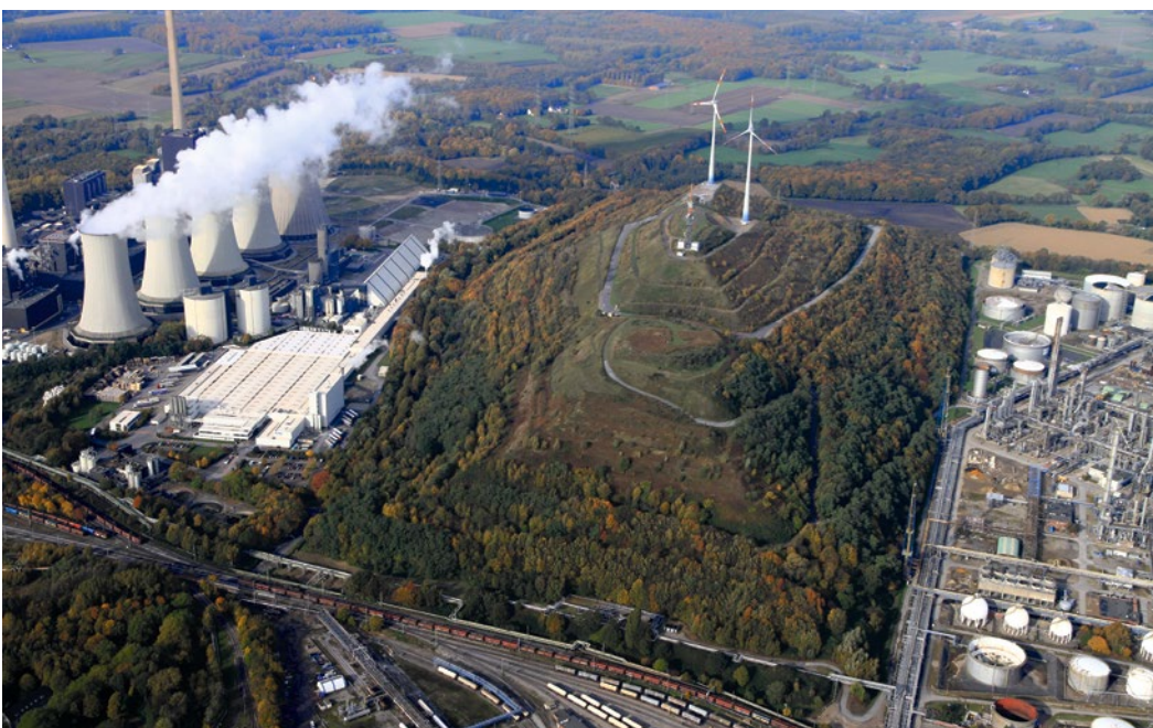
Windräder, Kraftwerk und Raffinerie, Gelsenkirchen-Scholven
