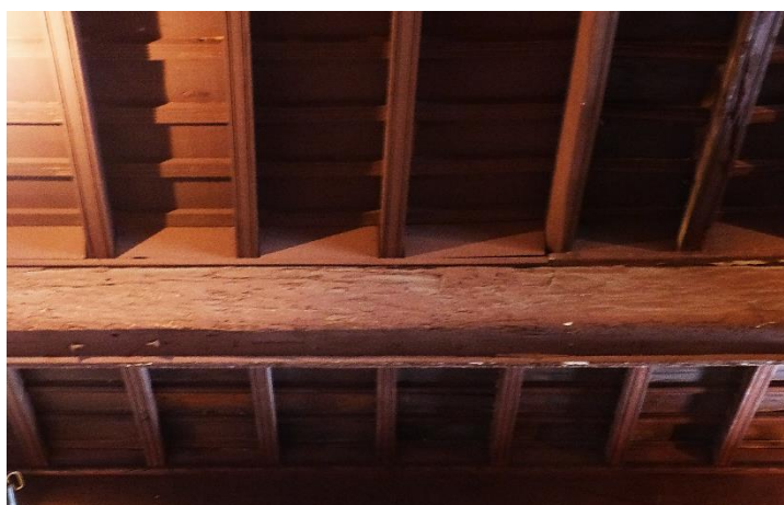
Techumbre de la celda 7-8 del MCSFC
