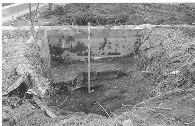
写真62 ①地点試掘既存基礎の状況（西より）
