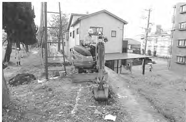
写真164 C地点掘削（北より）
