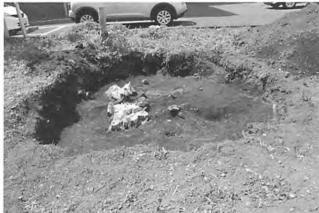
写真198 樹根④撤去完了状況（東より）
