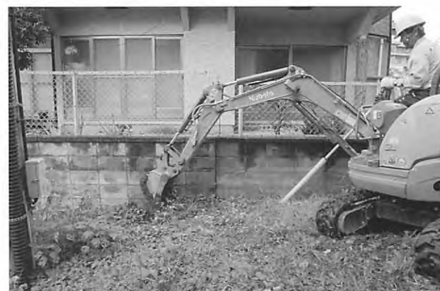
写真171 附小民家ブロック塀作業風景（南より）
