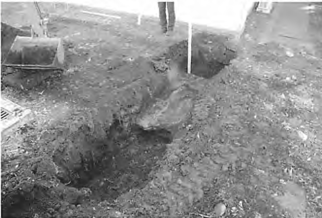
写真189 管理棟西側箇所掘削状況 (南西より)
