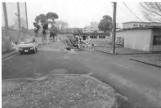
写真187 桝①掘削状況 (北より)
