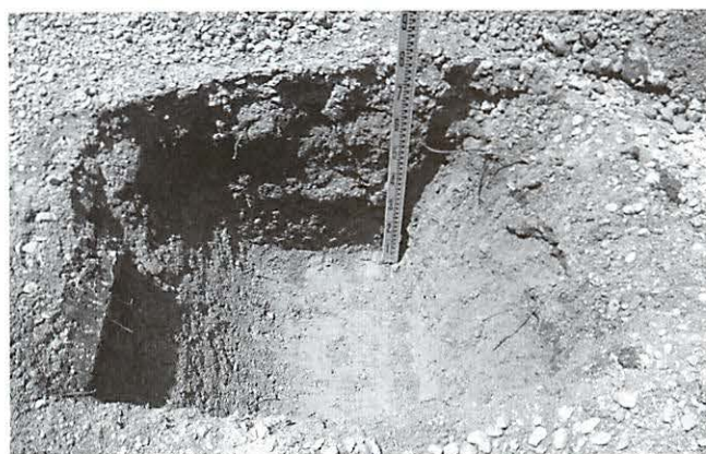
写真215 西側集水桝部分重機掘削作業風景(北東より)
