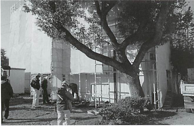
写真279 看板北側基礎掘削状況（東より）
