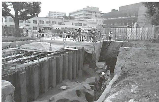
写真303 本荘北地区1321調査地点の現地説明会
