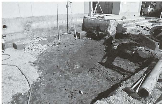
写真225 調査範囲西側掘削状況（南東より）
