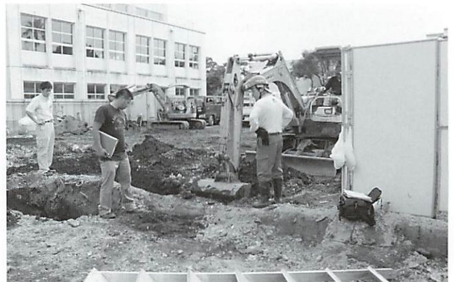
写真254 給水止掘削状況(北東より)
