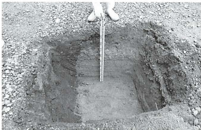
写真219 植樹部分重機掘削風景（東より）
