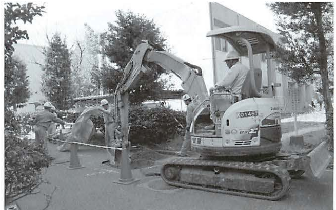
写真244 作業風景(北東より)
