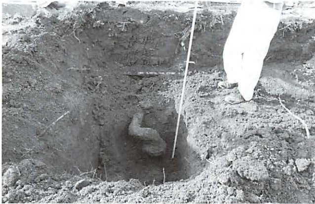
写真256 排水管①作業風景（南西より）
