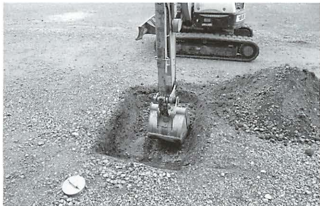
写真218 南側集水樹部分掘削状況（南西より）
