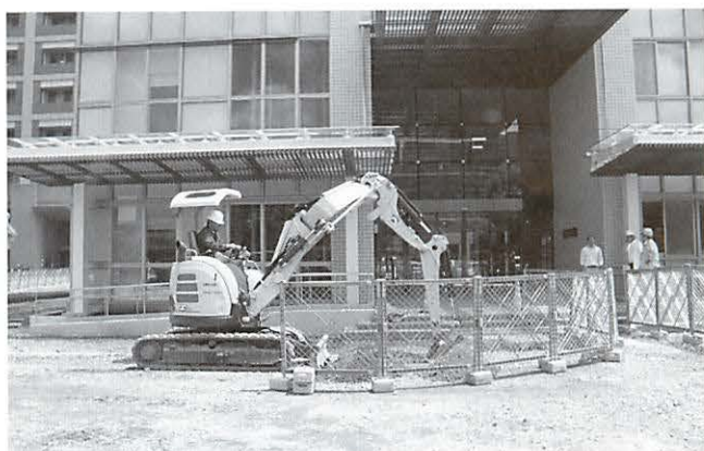
写真214 中央試掘地点掘削状況(南より)
