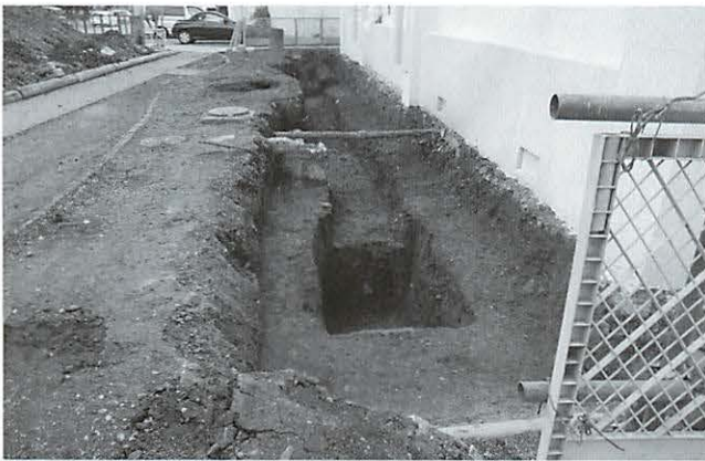
写真292 調理室外周北部遺構全景（北西より）
