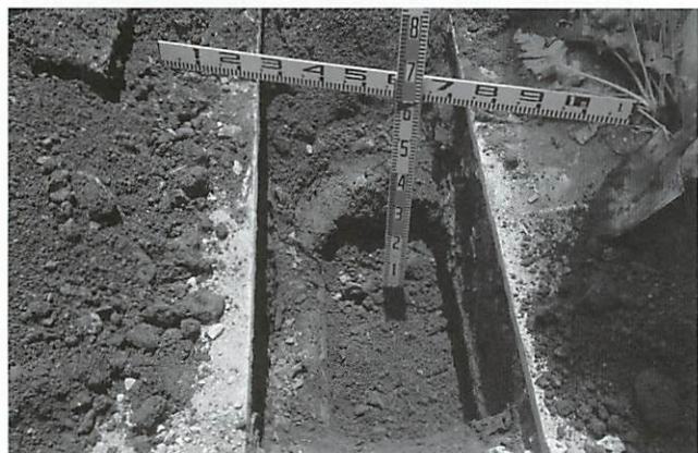
写真231 体育館東側作業風景（南より）
