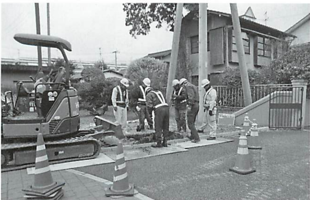
写真246 北門前作業風景（南東より）
