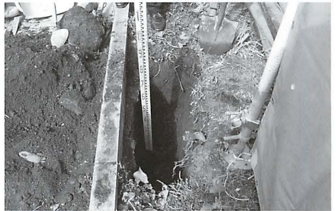
写真235 フェンス基礎撤去掘削状況（東より）
