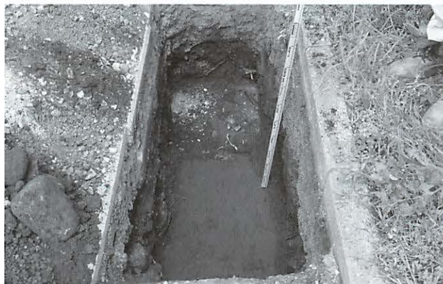
写真228 楷樹開館西側掘削状況（南より）
