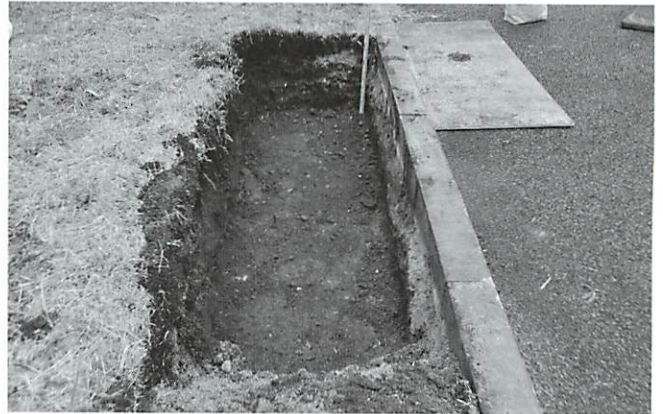
写真248 東門前作業風景（南東より）
