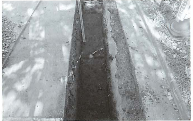
写真243 汚水管路掘削状況(西より)
