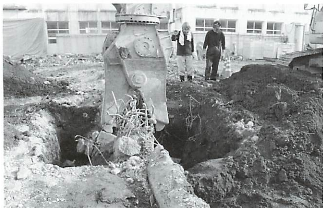
写真260 基礎撤去作業風景（北より）
