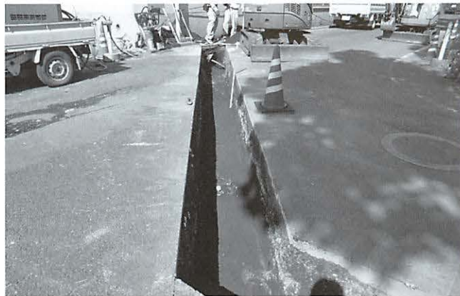
写真227 掘削状況（南西より）
