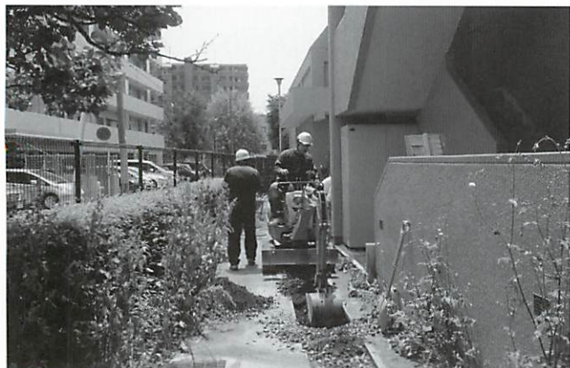
写真230 ⑦A棟東側掘削状況（北より）
