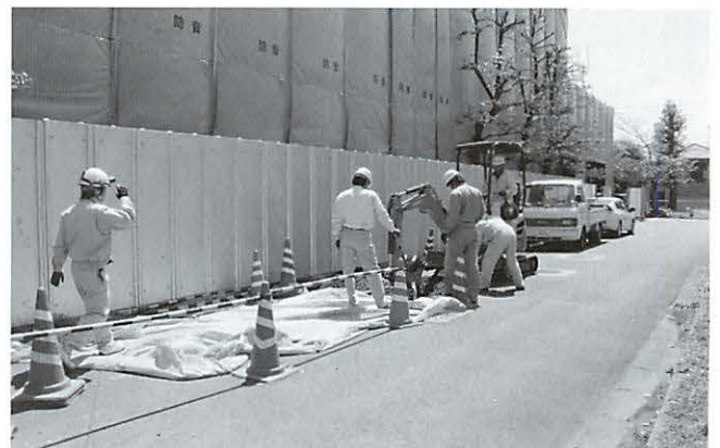
写真236 ④体育館西1作業風景（北西より）
