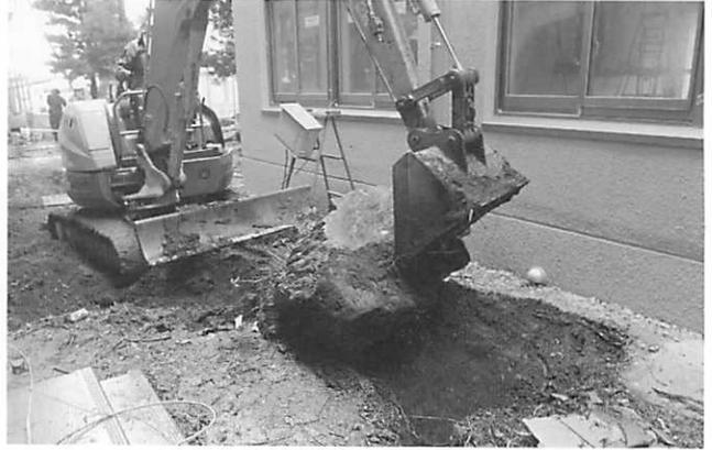
写真135 ②地点機械基礎粉碎作業風景（東より）
