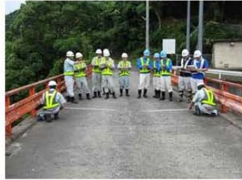
橋梁の点検作業 (奥浦橋) (大瀬戸町)
