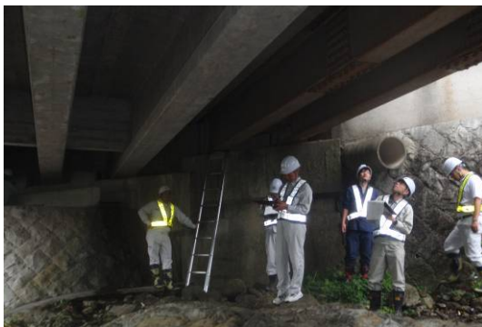
現場見学状況（洗切橋）
