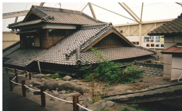
図8 ドーム内の被災家屋
