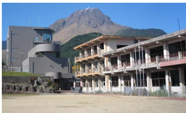
図6 大野木場小学校被災校舎とみらい館
