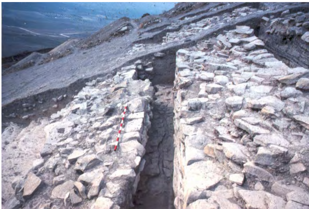
Fig. 229. Doble muralla calcolítica con corredor central, taller lítico y canal de desagüe de las fortificaciones en la ladera suroeste de «Los Alcores».
