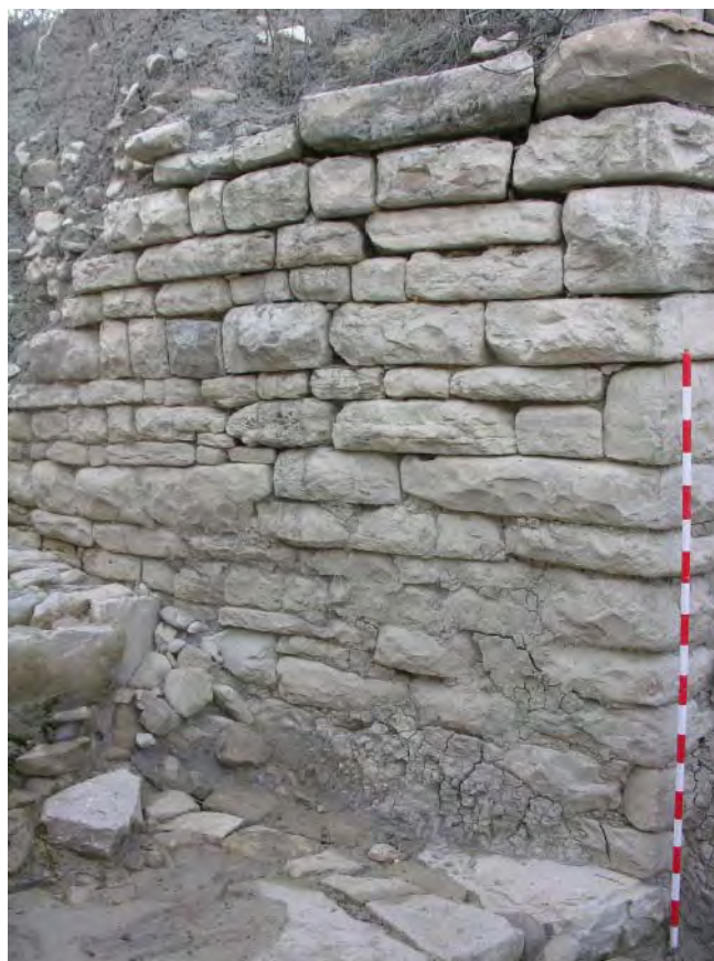
Fig. 544. Pared de sillares de la boca del horno de la calera del «Coloraíto», de Porcuna. Fuente: Fototeca de ARQUIPO. Sign.: 08 FD-2010-10-23-0098.
