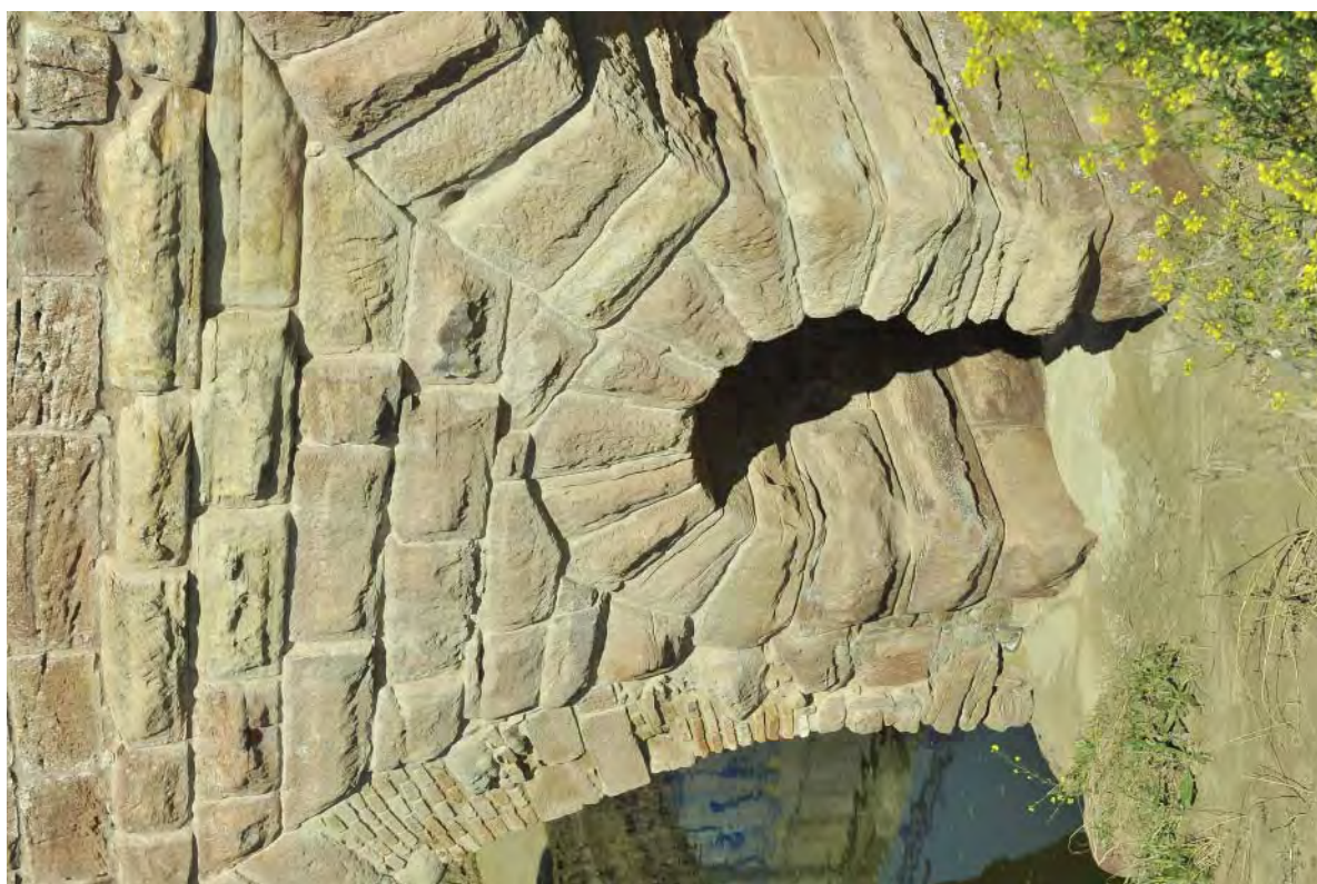
Fig. 542. Detalle de la fábrica de sillares almohadillados y engatillados del puente. Fuente: Fototeca de ARQUIPO. Sign.: FD-2017-03-24-ND700-062.
