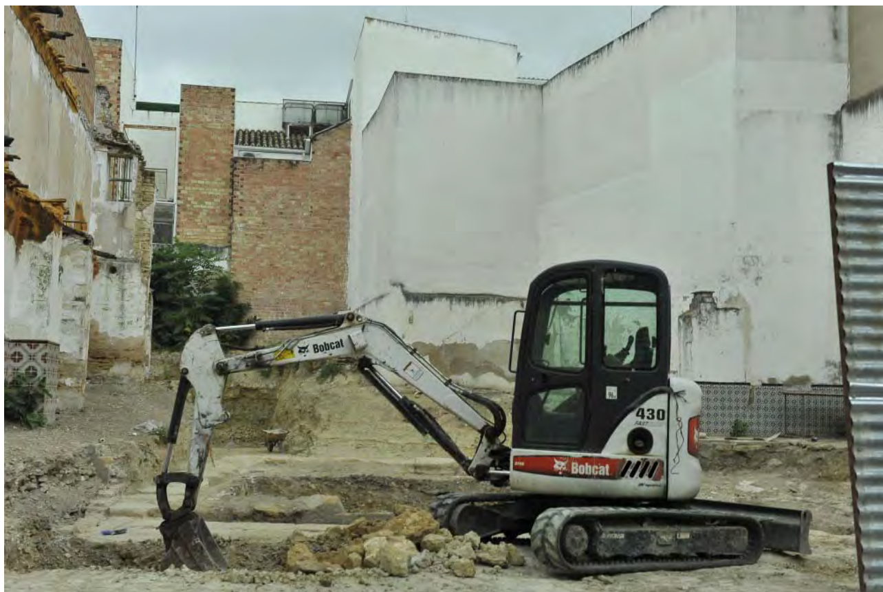
Fig. 423. Excavación con excavadora en la intervención de la calle Alharilla 24-26. Fuente: Fototeca de ARQUIPO. Sign.: FD-2015-09-16-ND700-082.
