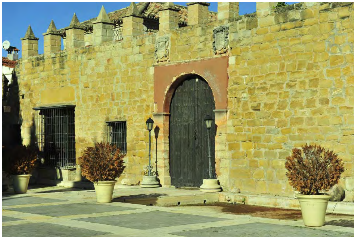
Fig. 142. Casa palacio de Mengibar. Fuente: Fototeca de ARQUIPO. Sign.: FD-2016-12-23-ND700-022.
