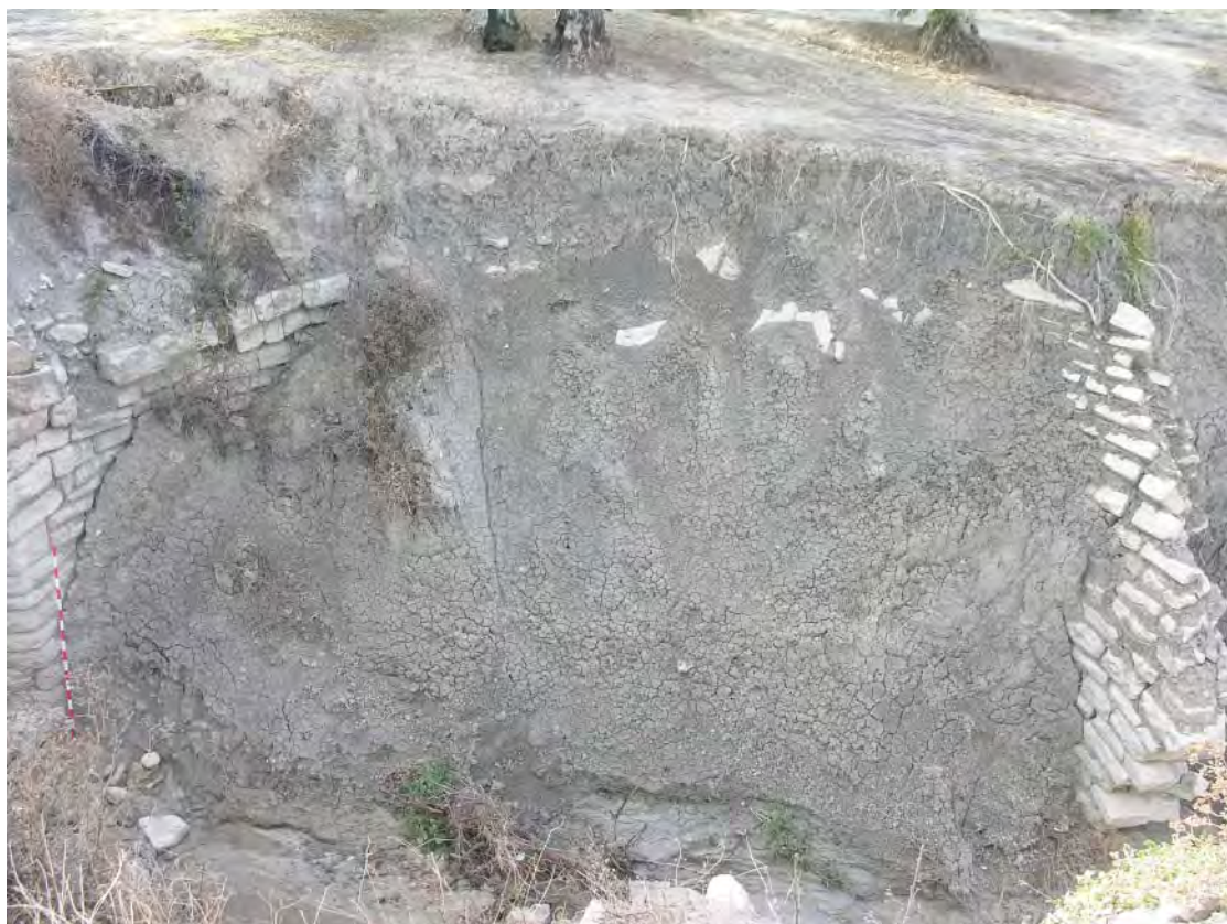
Fig. 545. Pared circular del horno de la calera del «Coloraító», de Porcuna. Fuente: Fototeca de ARQUIPO. Sign.: FD-2010-10-23-0095.
