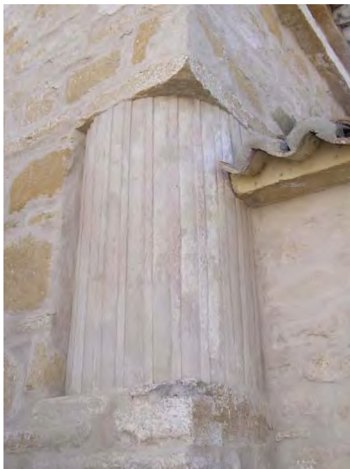
Fig. 284. Gran columna de un templo romano reutilizada en la esquina del lado este del complejo medieval del Priorato de San Benito. Fuente: Fototeca de ARQUIPO. Sign.: FD-2003-09-26-031.
