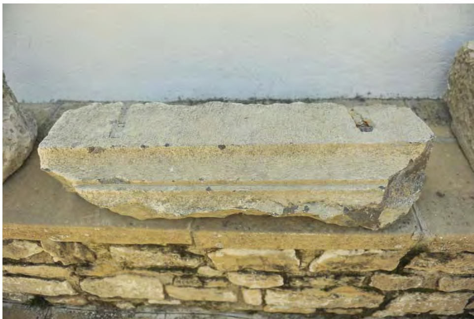
Fig. 427. Cornisa de caliza gris del mausoleo de la intervención de la calle Alharilla 24-26. Fuente: Fototeca de ARQUIPO. Sign.: FD-2017-02-17-ND700-292.
