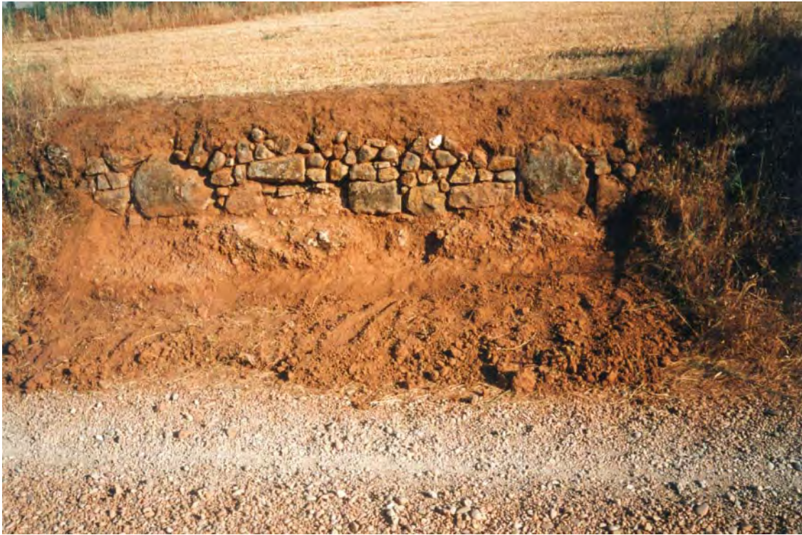
Fig. 187. Muro de contención de parcela en el «Veredón del Pino» con elementos arquitectónicos: sillares, algunos ciclópeos, y mampuestos reutilizados. Fuente: Ruíz Montes, 2012, 152, Fig 2,7.
