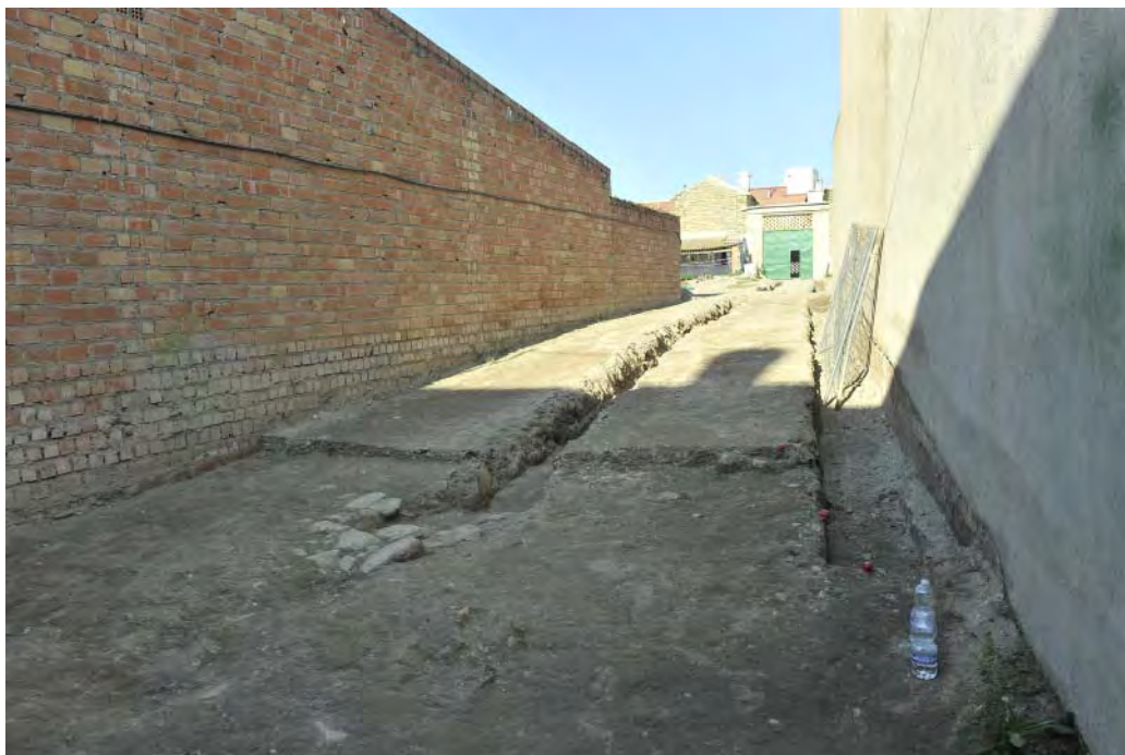
Fig. 301. Apertura de zanjas para instalación de infraestructuras con medios mecánicos en Ronda Marconi, 80.
