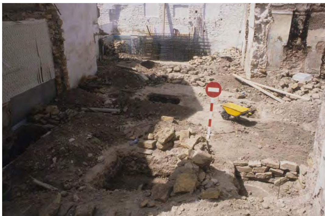
Fig. 335. Intervención en la calle Cervantes, 4. Fuente: Fototeca de ARQUIPO. Sign.: PJCM-Neg-1995-07-23 CALLE CERVANTES-003.
