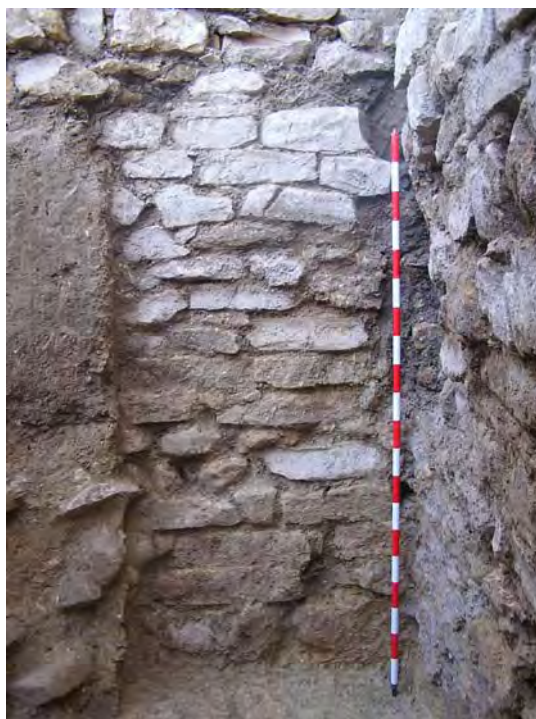
Fig. 338. Detalle de conservación de los muros domésticos romanos en los patios del Ayuntamiento. Fuente: Fototeca de ARQUIPO. Sign.: FD-2004-11-25-015.
