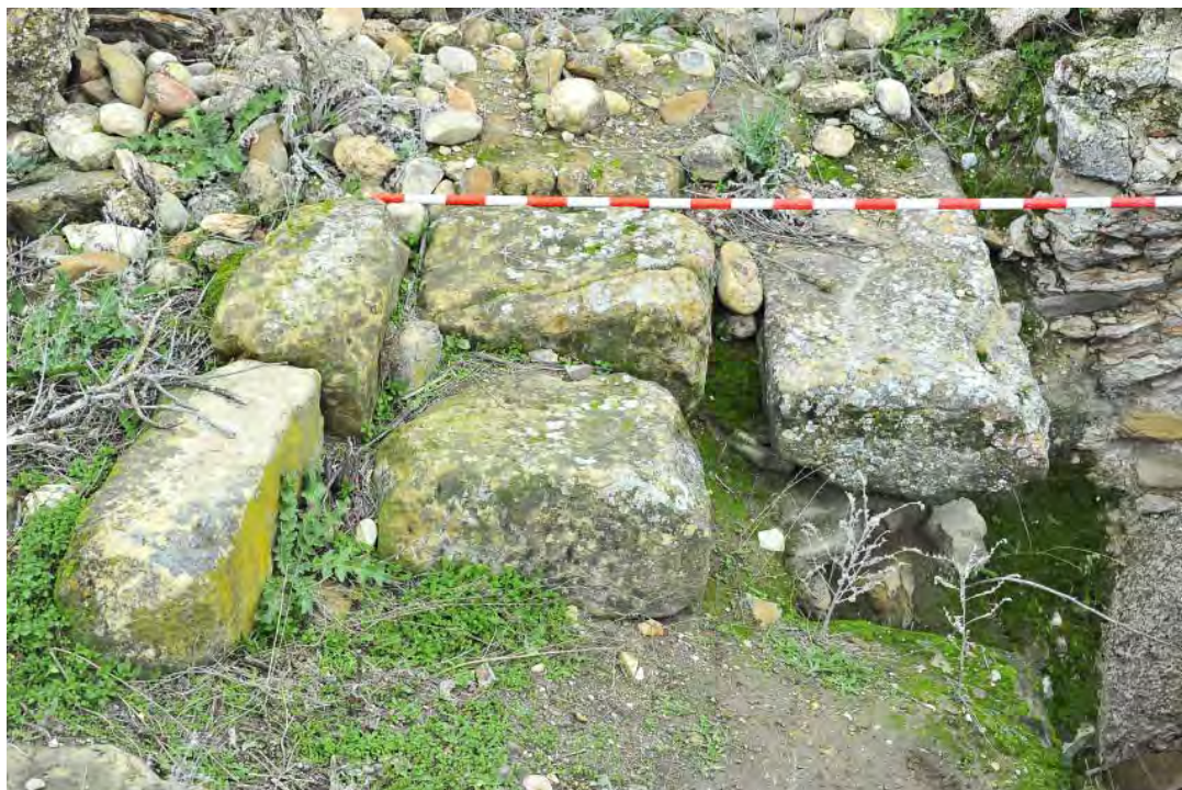
Fig. 136. Muro de bloques ciclópeos de un edificio cuadrangular anexo por el norte con la cisterna. Fuente: Fototeca de ARQVIPO. Sign.: FD-2016-12-03-ND700-607.
