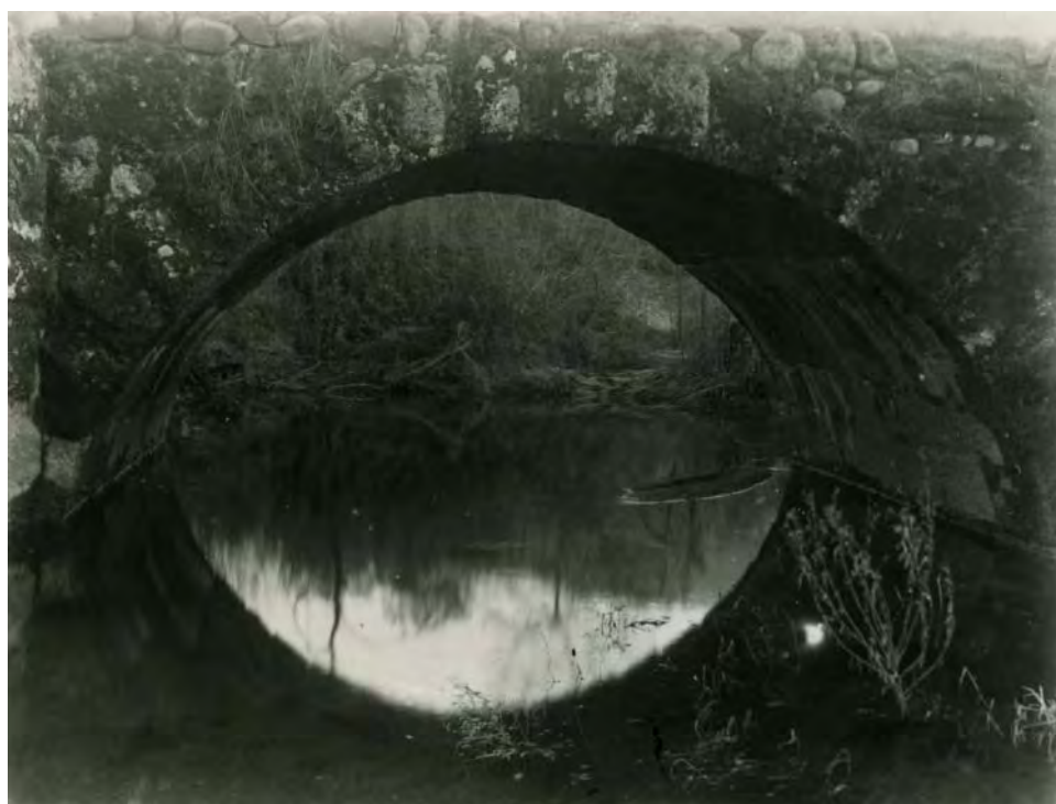
Fig. 524. Vista de uno de los ojos del puente sobre el Jándula (Andújar). Fuente: IEG-FOT-EST-1364.
