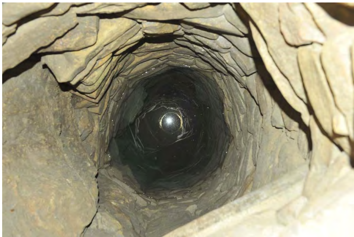
Fig. 328. Pozo excavado en la roca en la calle José de Quero, 19. Fuente: Fototeca de ARQUIPO. Sign.: FD-2014-06-26-ND700-038.
