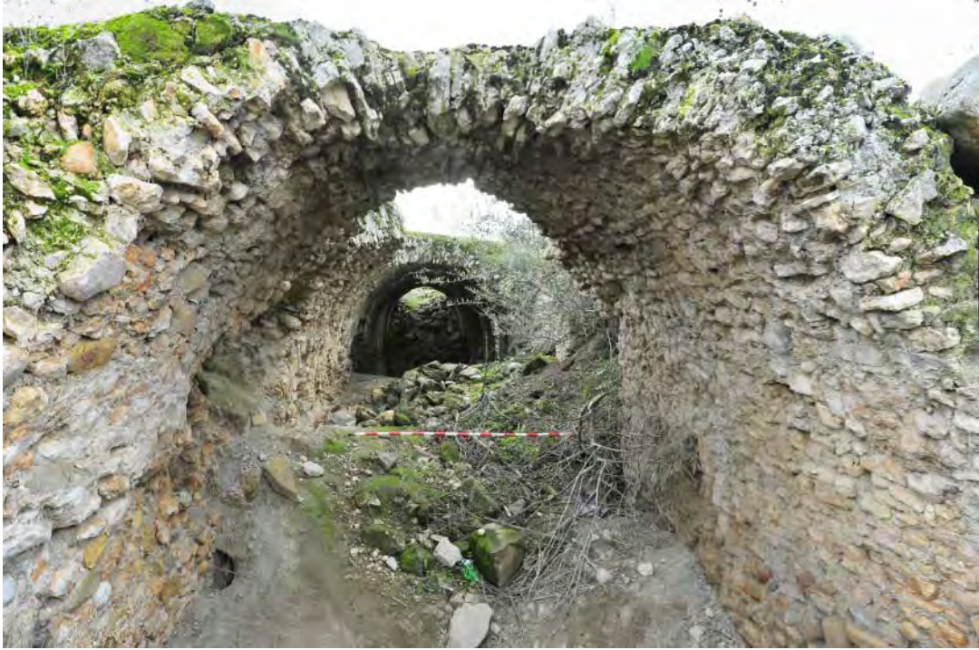
Fig. 131. Interior de la cisterna de «Cerro de Maquiz» desde el norte. Fuente: Fototeca de ARQVIPO. Sign.: Pan-2016-12-03-537-540.
