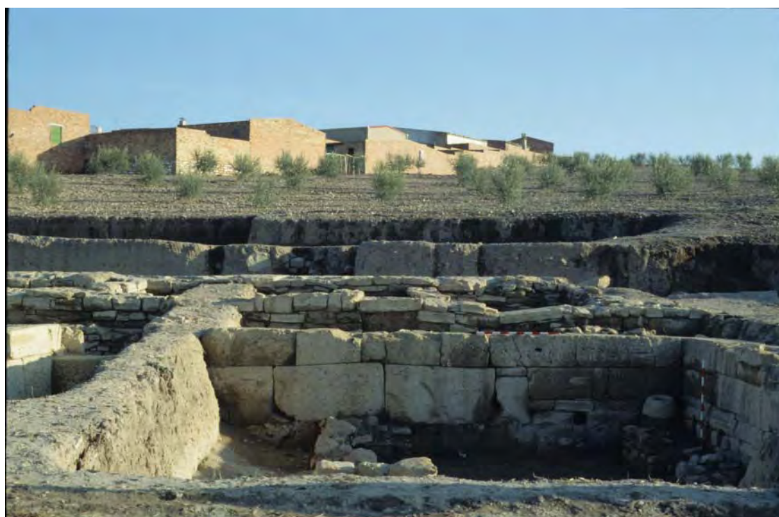
Fig. 266. Vista desde el norte del patio de la “Casa del patio en hondo”. Fuente: Fototeca de ARQVIPO. Sign.:PJCM-Diap-045-005.
