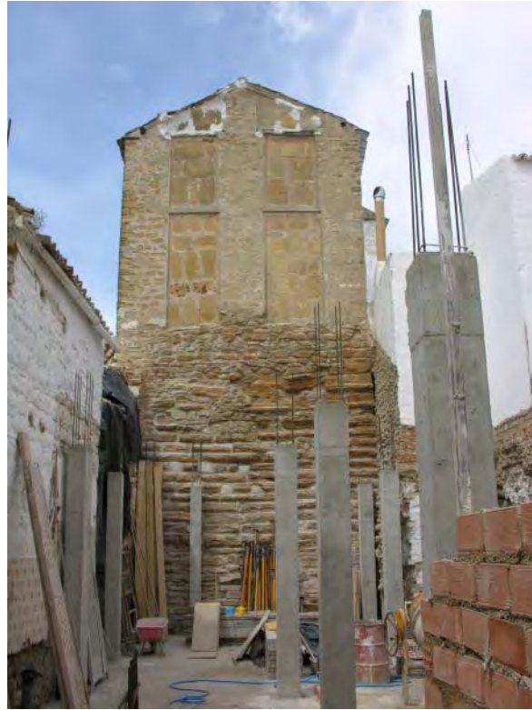
Fig. 373. Vista de la obra de Alférez Manuel Casado, 24, con los pilares adosados a la torre romana. Fuente: Fototeca de ARQUIPO. Sign.: FD-2006-04-01-002.
