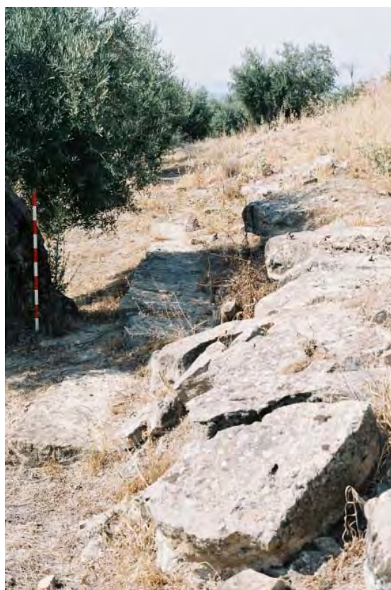
Fig. 221. Antiguos frentes de cantera en escalera en la «Cañada Rasgavaras». Fuente: Fototeca de ARQUIPO. Sign.: FESH-Neg-2003-012-027.
