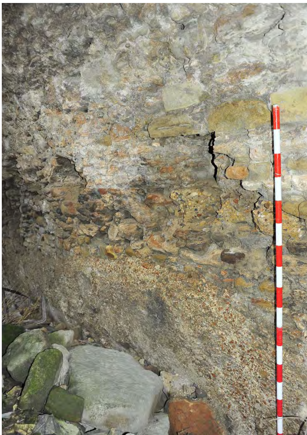
Fig. 133. Revoco de opus signinum en el interior del muro oriental de la cisterna de «Cerro de Maquiz». Fuente: Fototeca de ARQUIPO. Sign.: FD-2016-12-03-ND700-562.
