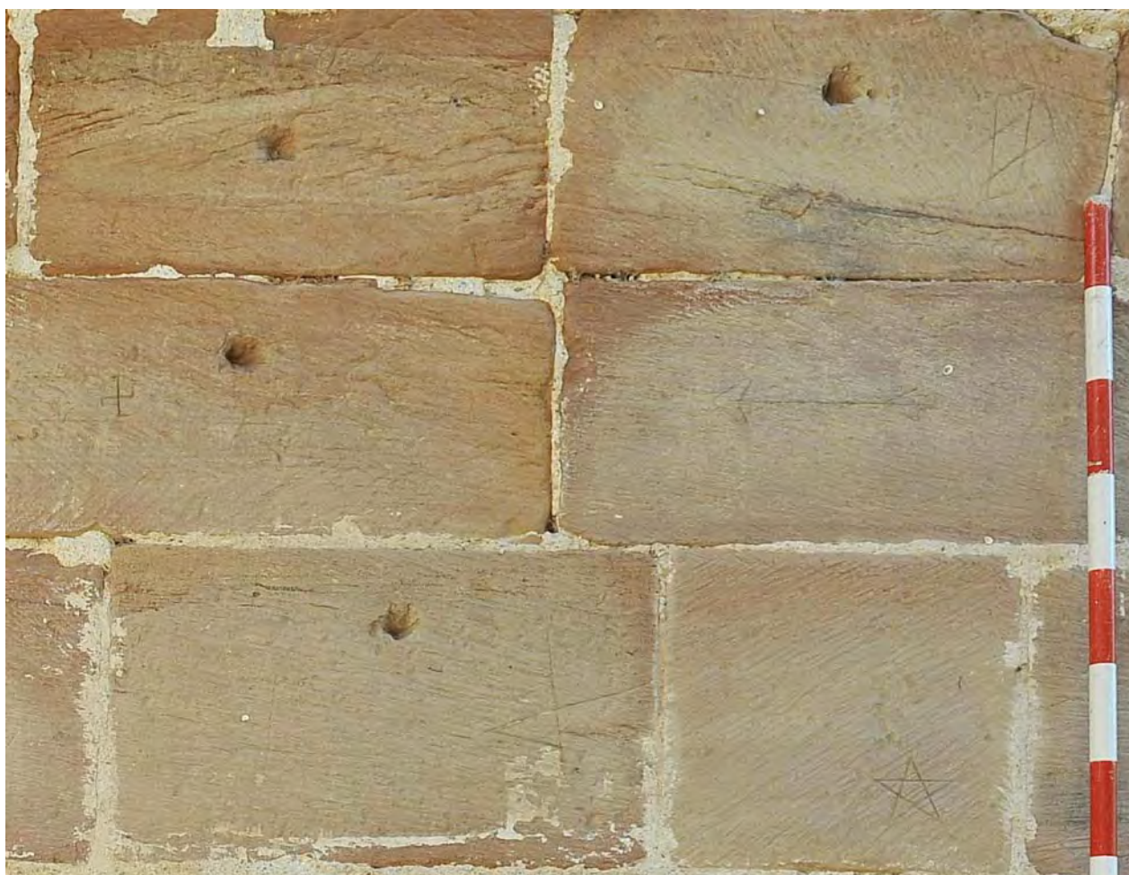
Fig. 530. Marcas de cantería medievales en los sillares del puente viejo de Andújar. Fuente: Fototeca de ARQUIPO. Sign.: FD-2017-03-24-ND700-149m.
