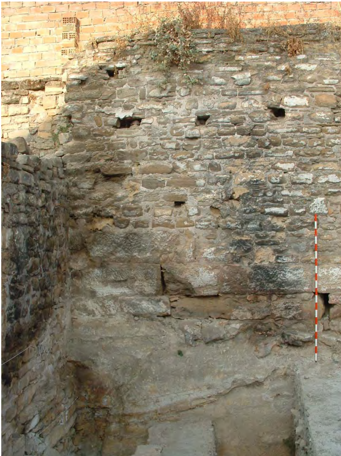
Fig. 291. Detalle del muro oeste del priorato que se asienta sobre un gran muro de sillares, que a su vez se asienta sobre una fase de cantera.
