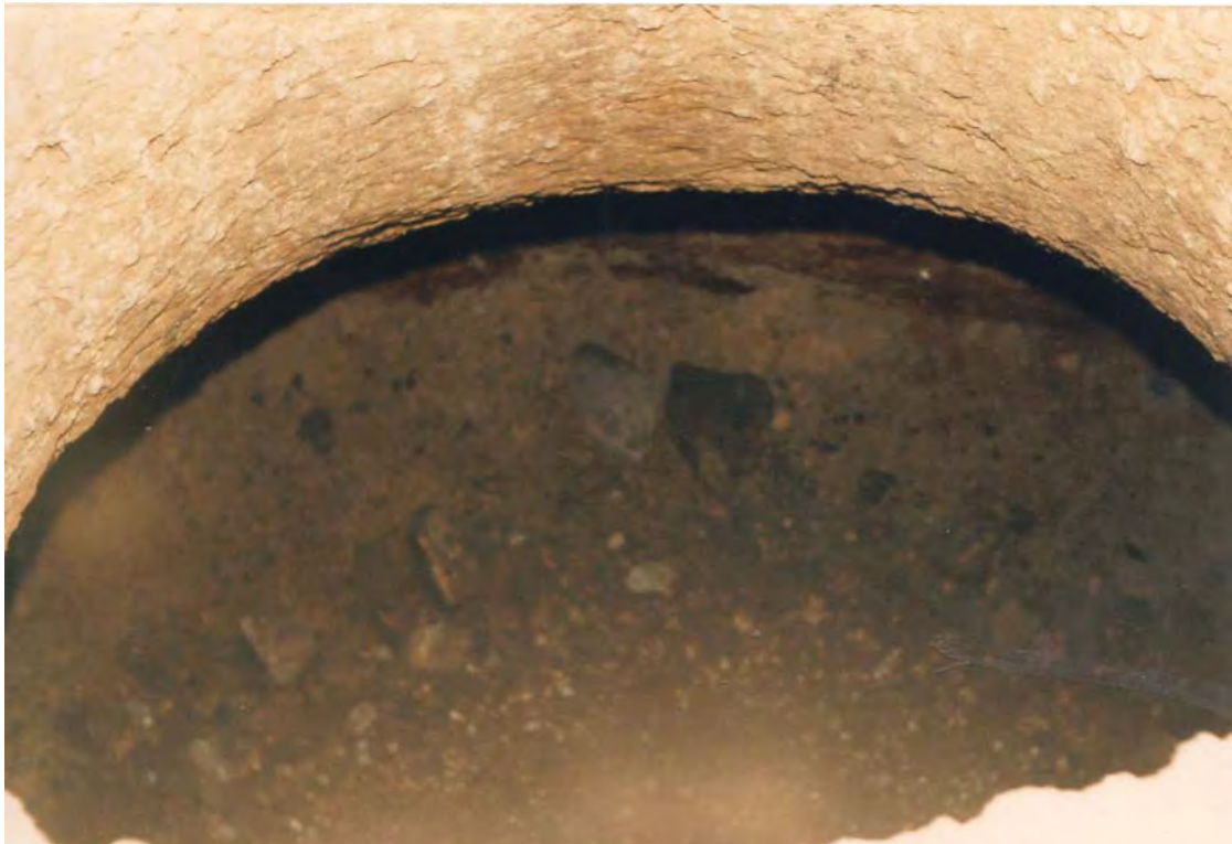
Fig. 399. Detalle interior del mismo silo. Fuente: Fototeca de ARQUIPO. Sign.: PJCM-110.
