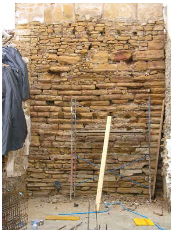
Fig. 372. Vista del muro frontal de la torre romana de Alférez Manuel Casado, 24, tras ser picada. Fuente: Fototeca de ARQUIPO. Sign.: FD-2006-03-19-003.
