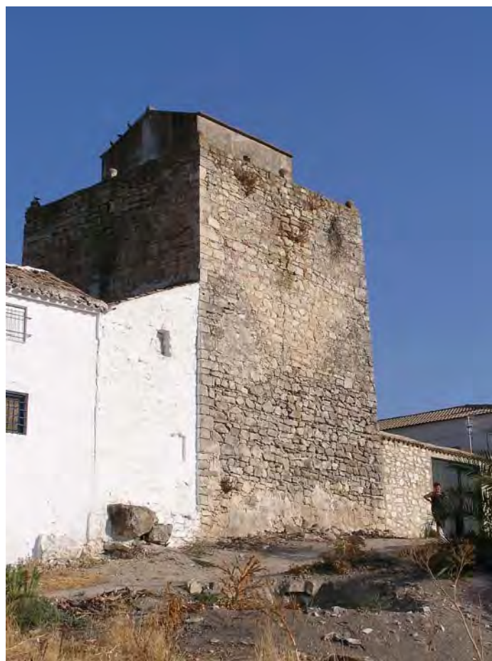
Fig. 492. La «Torre de Alcázar» calatrava (Torredonjimeno). En su base, restos de un recinto fortificado romano. Fuente: Fototeca de ARQVIPO. Sign.: FD-2003-09-06-179.
