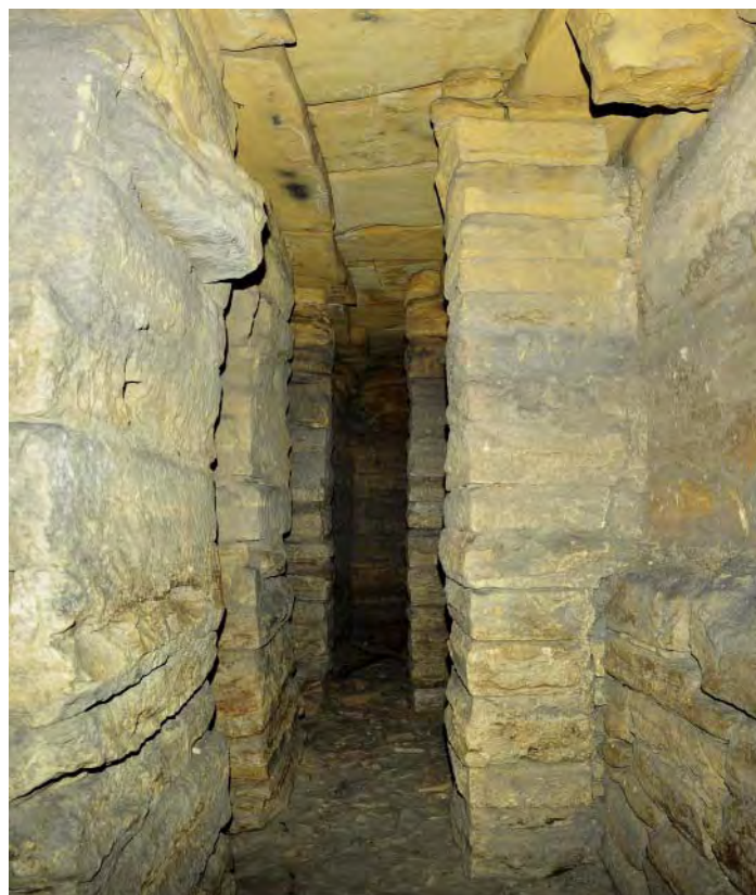
Fig. 312. Vista del lateral occidental de la cisterna de «La Calderona». Fuente: Fototeca de ARQUIPO. Sign.: Pan-2014-09-06-079-081_1.
