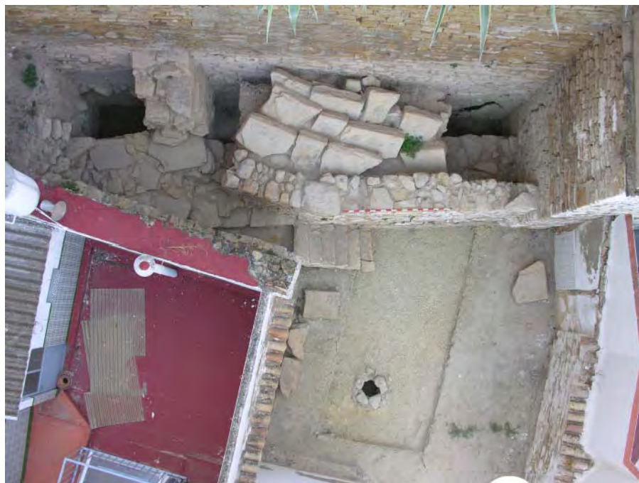
Fig. 387. Vista aérea de la muralla romana en Carrera de Jesús, 28. Fuente: Fototeca de ARQVIPO. Sign.: FD-206-07-17-028.
