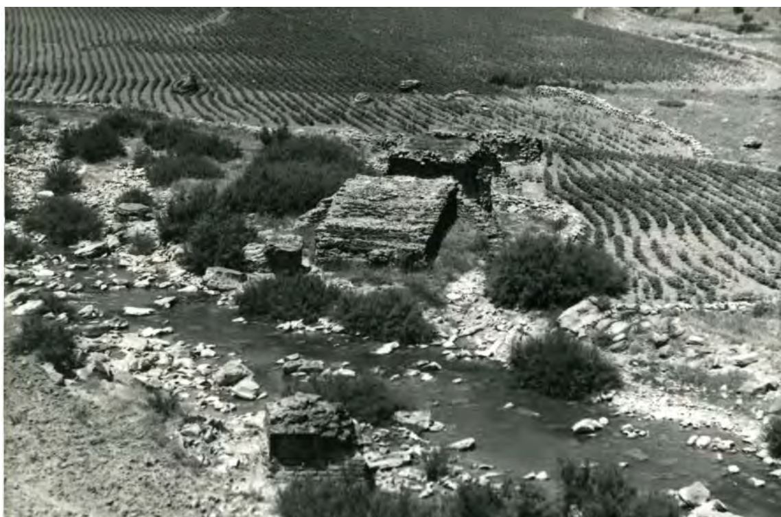
Fig. 546. Vista antigua del Puente de Cañete, sobre el río Salado de Porcuna, del s. XVIII. Fuente: Fototeca de ARQUIPO. Sign.: RBS-C13-0168.
