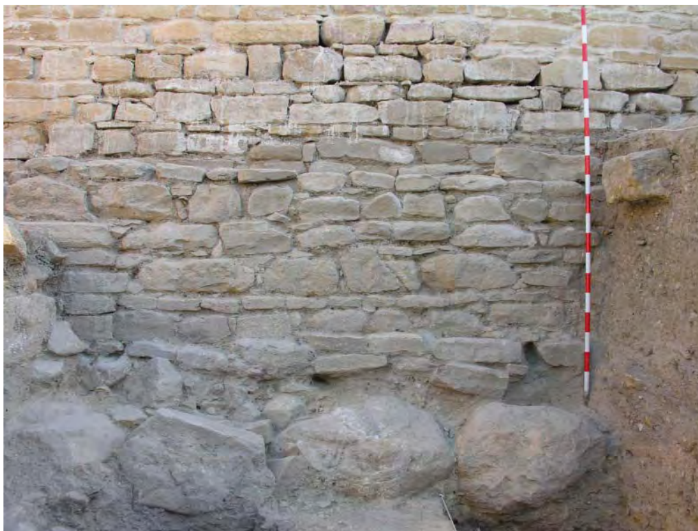
Fig. 377. Vista de alzado de la muralla romana y medieval sobrepuesta en la intervención en la calle General Aguilera, 36.
