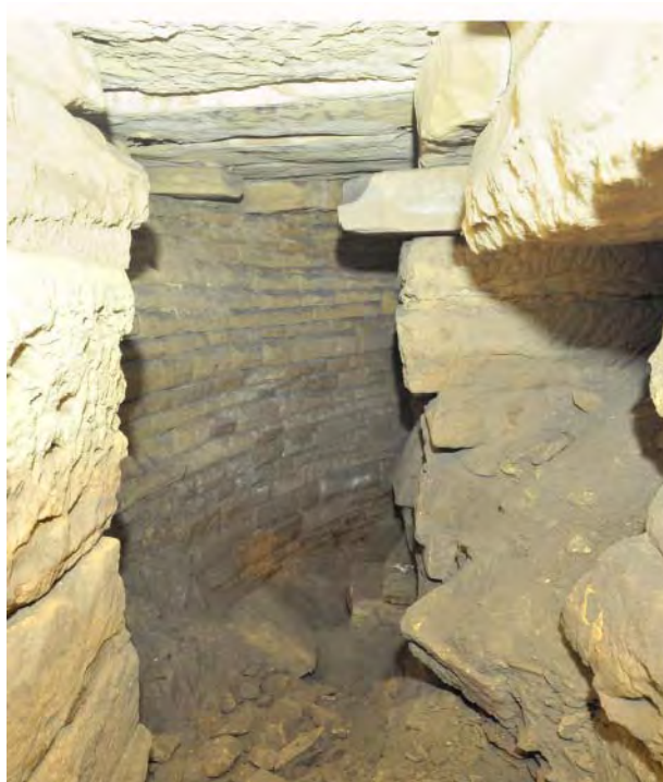
Fig. 314. Vista del muro curvo de la zona sur de la cisterna de «La Calderona». Fuente: Fototeca de ARQUIPO. Sign.: Pan-2014-09-07-237-239.
