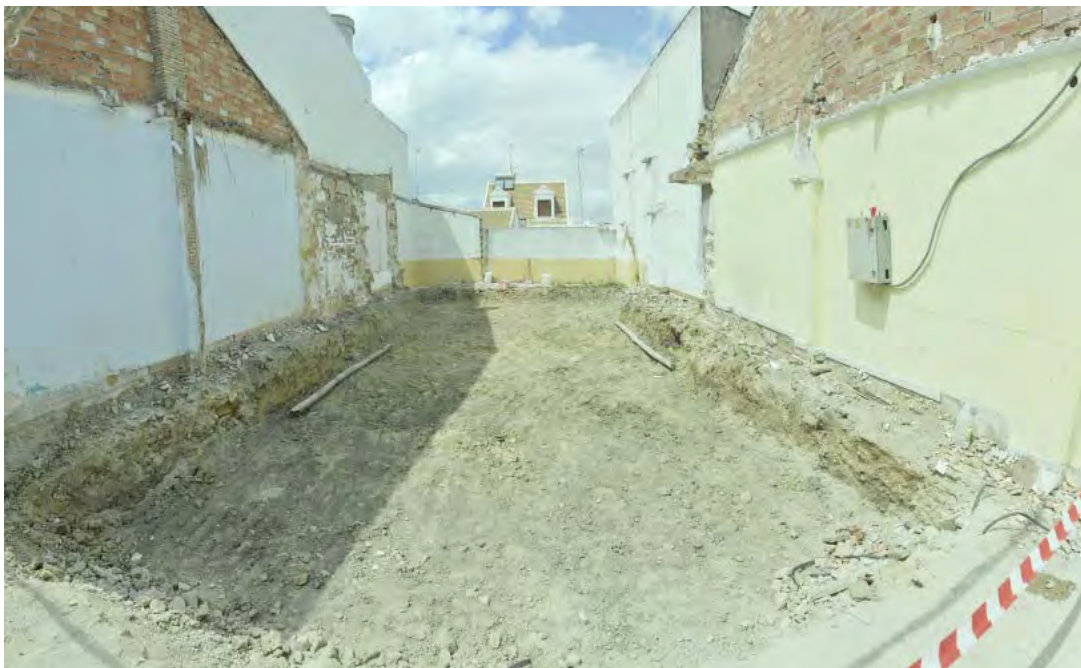
Fig. 430. Control de movimientos de tierras en calle Primero de Enero, 11.
