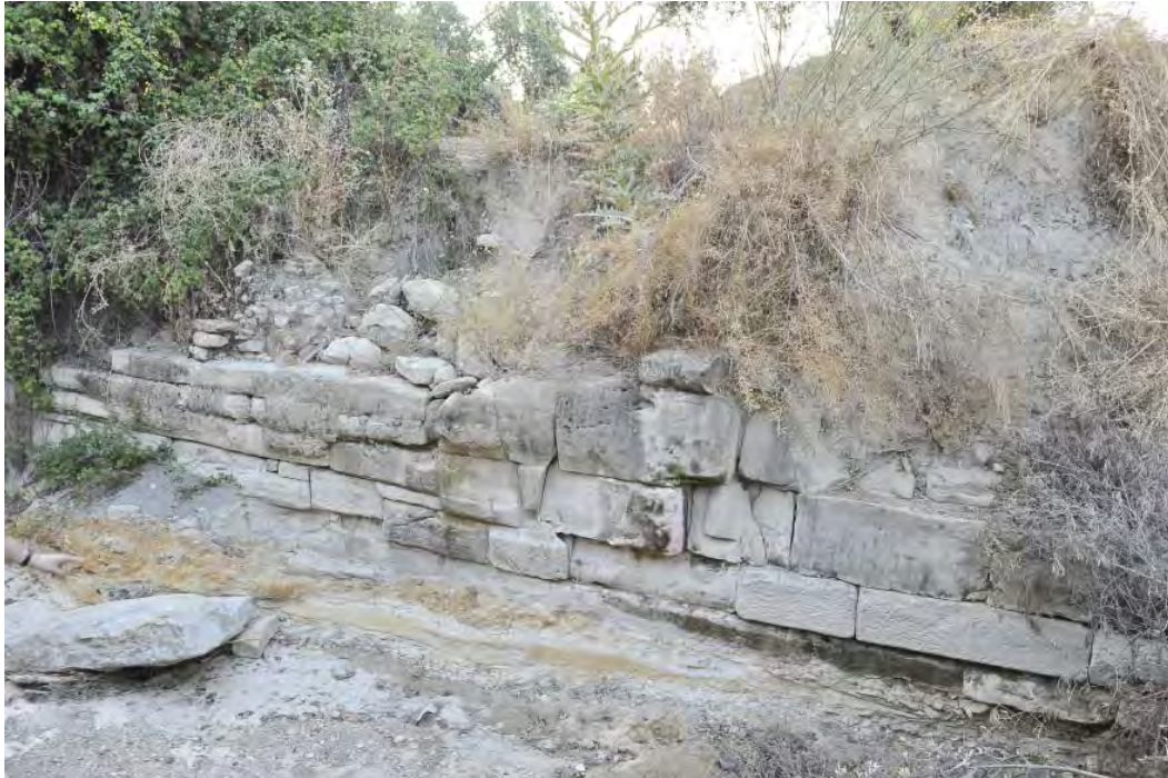
Fig. 556. Pared de sillería de la piscina o estanque de «Los Hervieros», Arjona.
