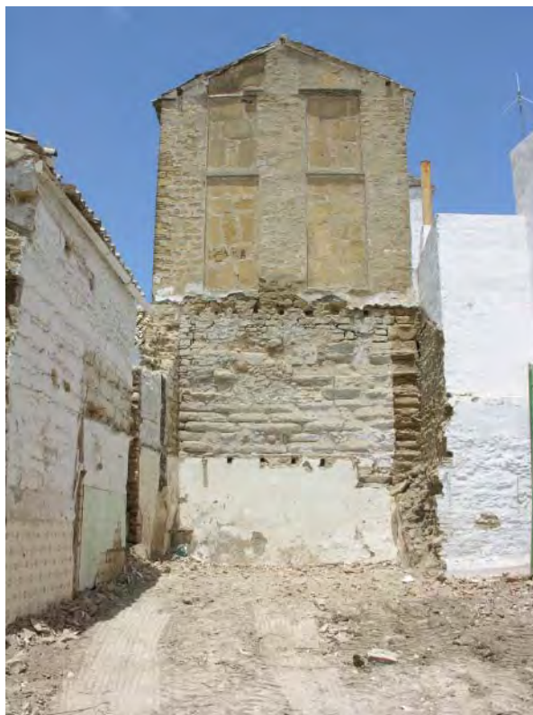
Fig. 371. Vista de la torre romana de sillares del n.º 24 de la calle Alférez Manuel Casado. Fuente: Fototeca de ARQUIPO. Sign.: FD-2005-06-28-003.
