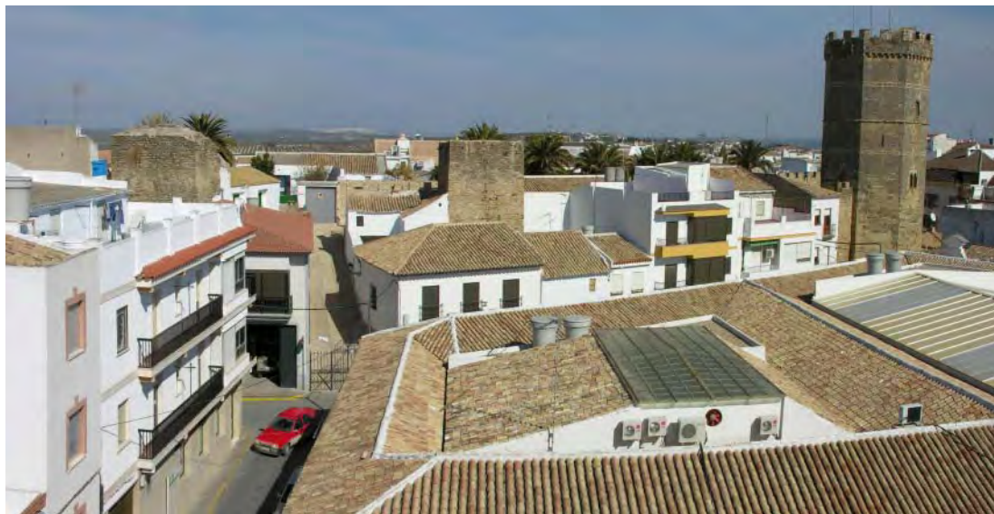
Fig. 344. Vista desde el Oeste de los restos de torres del Castillo de Porcuna.
