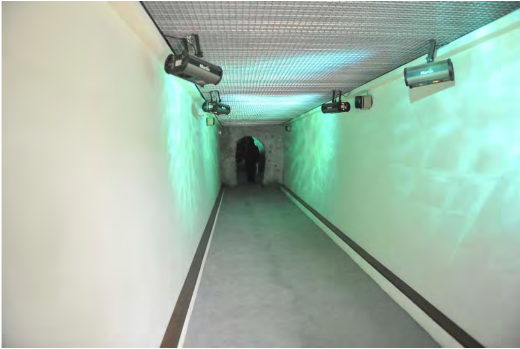
Fig. 487. Túnel de entrada al aljibe, construido recientemente destruyendo enormes depósitos arqueológicos.
