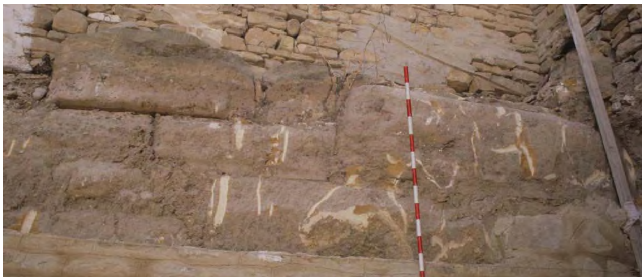
Fig. 368. Detalle del muro de sillares romano de Alférez Manuel Casado, 6. Fuente: Fototeca de ARQUIPO. Sign.: PJCM-Sardinas-1995-002mod.
