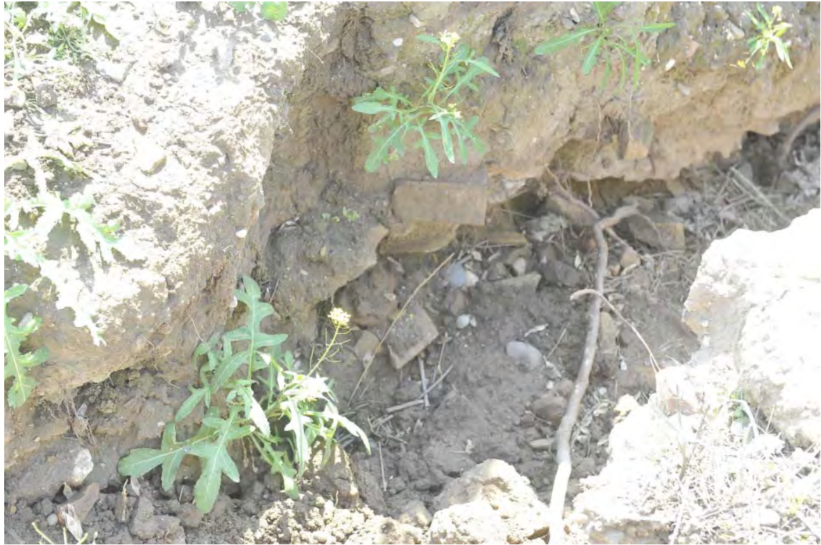
Fig. 185. Restos de derrumbes y registros exhumados por la erosión en los bordes de la meseta de «Los Villares» de Andújar.
