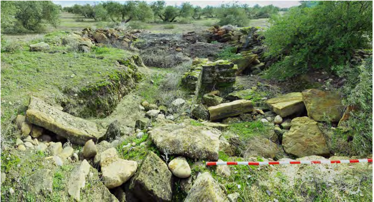
Fig. 19. Estado actual y deterioro de los restos del Sacellum del foro de Iliturgi en «Cerro Maquiz». Fuente: Fototeca de ARQUIPO. Sign.: Pan-2016-12-03-281-284
