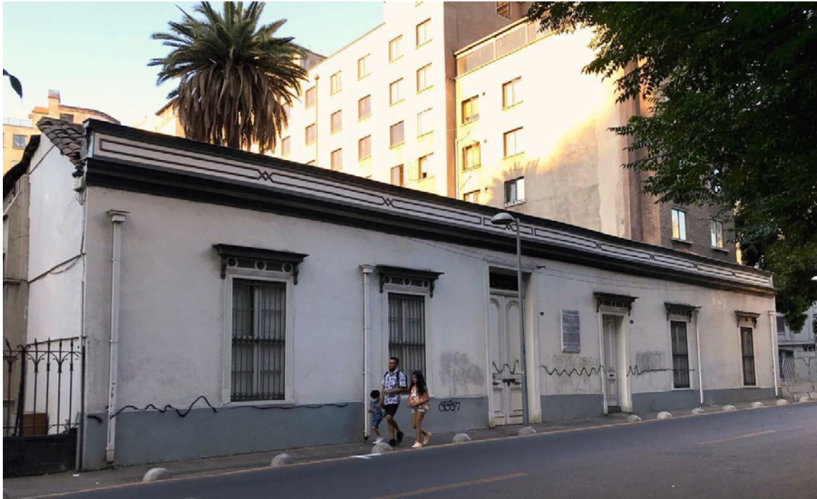
Fig. 7. Fotografía actual de la Casa Santo Domingo.
