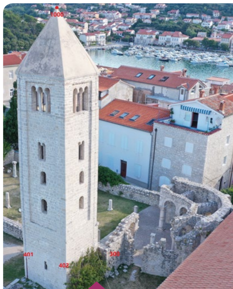
SLIKA 5. RASPORED KONTROLNIH TOČAKA NA JUŽNOM I ISTOČNOM PROČELJU ZVONIKA (KAŠTELAN 2020).
