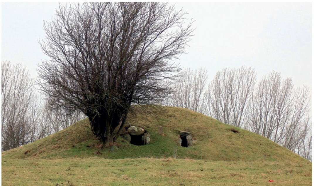
Fig. 12a og b. Dobbeltjættestue (også kaldet Tvillingejættestuen) ligger sydvest for Gundsølle (A.P. Madsen). På Madsens akvarel ses øverst dækstenene over jættestuens kamre. Der er fyldt jord på højen ved restaureringer i 1901 og 1919. 1989 er der bl.a. inde i kammeret foretaget ny afstivning af loftet med et stort vinkeljern. Foto: Ib Nielsen.
