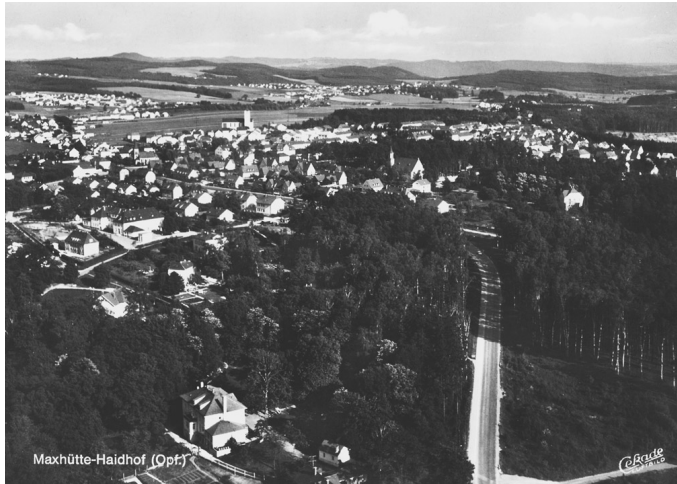
Abb. 45: Straßenneubau, Luftbildfotografie l. u. Fromm-Villa, Fotografie 1966, Sammlung Gschwendner
