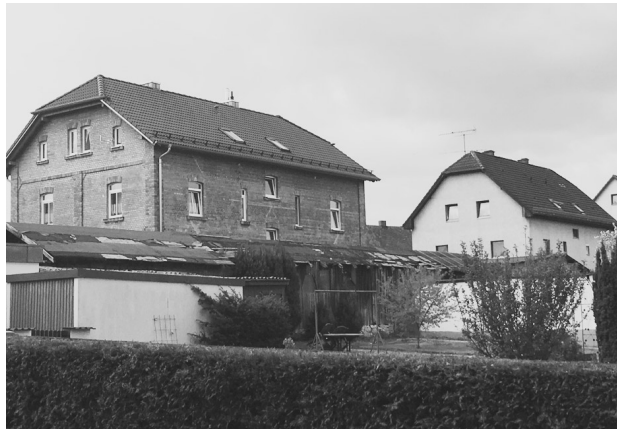
Abb. 18: Links, Sechsfamilienarbeiterhaus, Schwandorfer Straße 1, (vormals Sechserweg), Schlackenstein, 1908, rechts, Arbeiterhaus, Engelbert-Gstettenbauer-Str. 6, (vormals Sechserweg), 1920, Fotografie 2018, Schmidkunz
