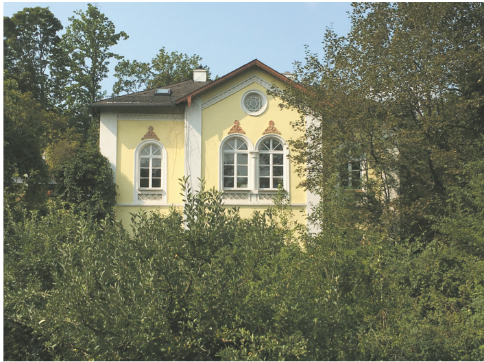
Abb. 10: Ziegler-Villa, Ostfassade, Fotografie 2021, Schmidkunz
