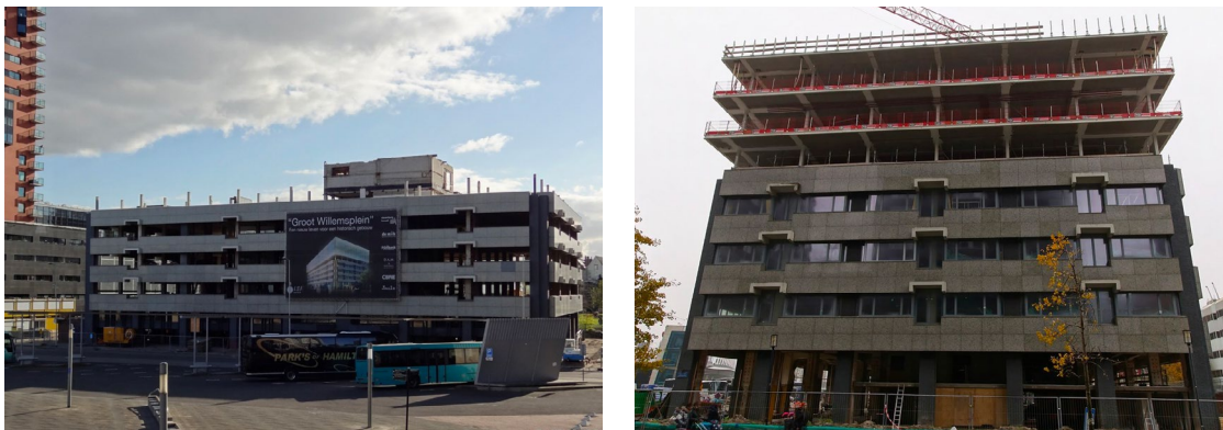
Fig.2 - A sinistra prima del cantiere; a destra durante i lavori di ristrutturazione (Source: 2012 TOPAAS)
