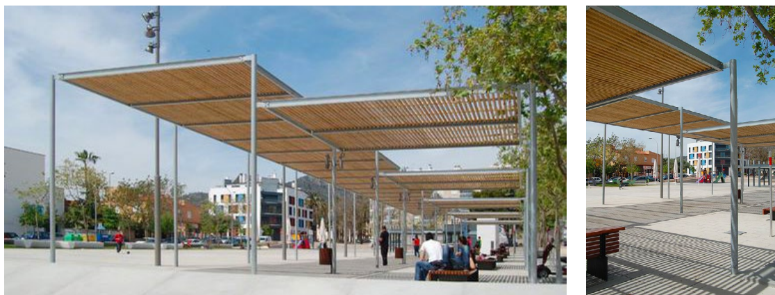
Fig. 1 - Copertura urbana realizzata in acciaio e legno nella piazza di Benicasim, Spagna (Source: Microarquitectura ).
