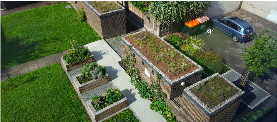
Fig.1 - Richard Knight House. Tetti verdi, rain gardens, alberi da frutto e superfici verdi permeabili si combinano insieme per fornire servizi ecosistemici che costruiscono la resilienza ai cambiamenti climatici (Source: Dr. Stuart Coppon)
