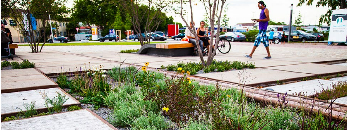
Fig.3 - Dettaglio della pavimentazione realizzata con materiali riciclati e di una fioriera drenante (Source: Brian Doherty)
