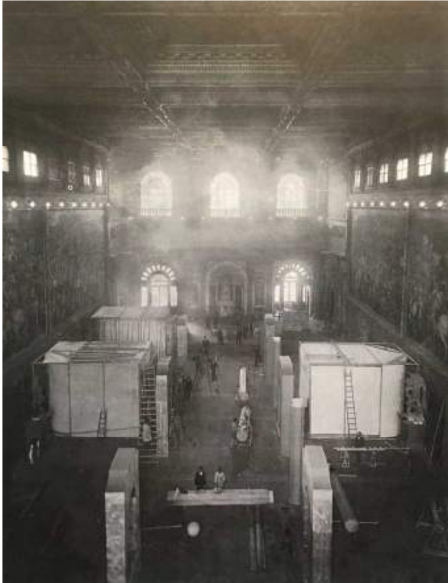
Fig. 1. Room 1: the Salone dei Cinquecento with the installation underway of the ten teatrini , Florence, Gabinetto Fotografico delle Gallerie degli Uffizi. Courtesy Ministero per i Beni e le Attività Culturali.
