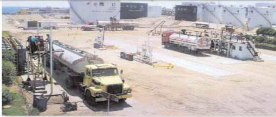
Zona de despacho y tanques. / Dispatch and tanks area.
