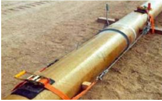
Figura 29. Grapas para junta a presión para unión de tuberías FRP
