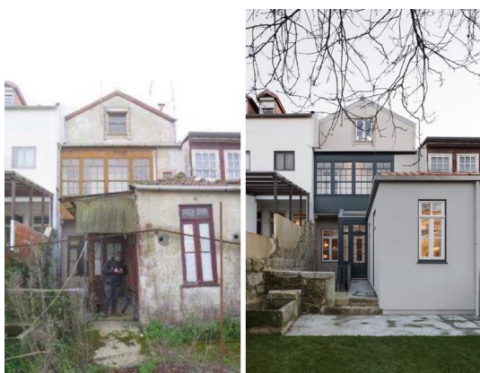
Figura 47. Fachada trasera antes/después
