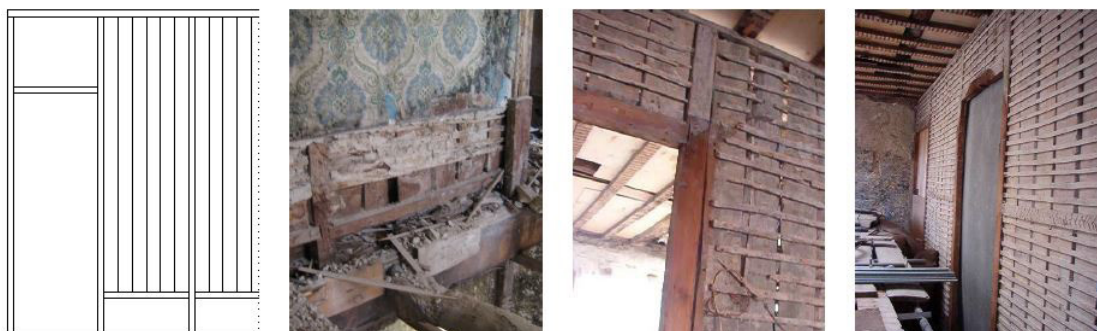
Figura 24. Esquema básico de tabiquería de madera
