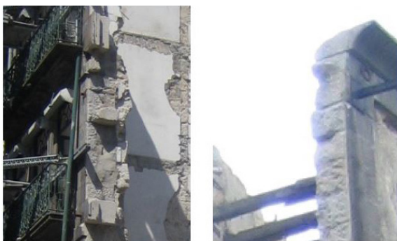
Figura 16. Fachadas de paño doble y simple
