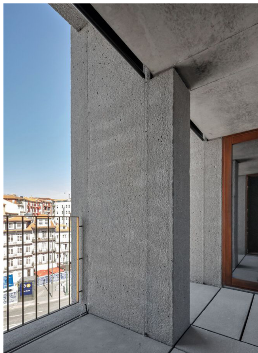
Figura 56. Vista interior São Bento Residences
