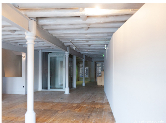
Figura 33. Ascensor y estructura preexistente MVP
