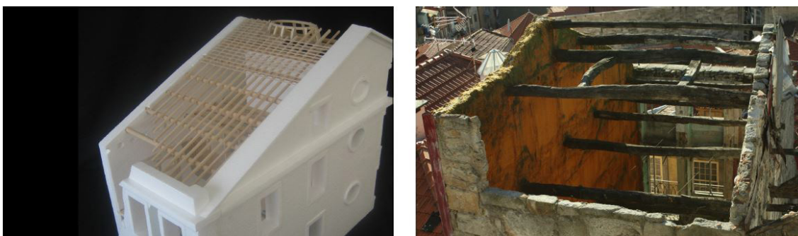
Figura 23. Estructura de cubierta a dos aguas en el sentido longitudinal
