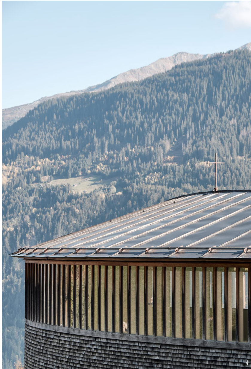
Figura 4: Peter Zumthor, fotografía exterior de Capluta Sogn Benedetg, Sumvitg, Grisones (1985-1988)
