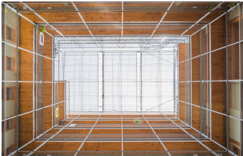
Fig 148. La Borda / Lacol. Cubierta del invernadero vista desde el patio. Archdaily. Fuente: https://www.archdaily.com.br/br/945797/edificio-la-borda-lacol (consultado el 28 de agosto de 2021)
