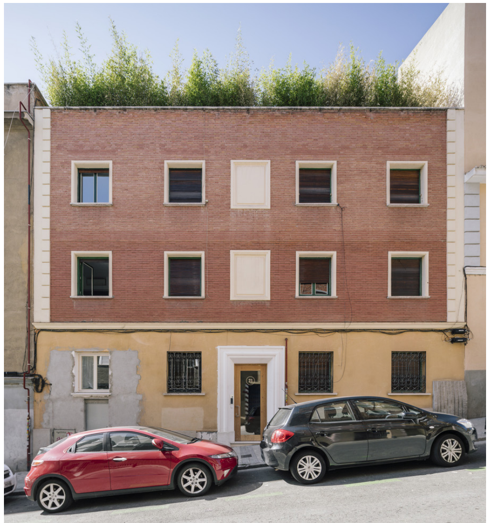
Fig 108. Ch+qs arquitectos. Fachada original que da a la calle Oubrid. Elle Decor. Fuente: https://www.elledecor.com/es/arquitectura/a33480361/coliving-madrid-tetuan-apartamento/ (consultado el 6 de septiembre de 2021)
