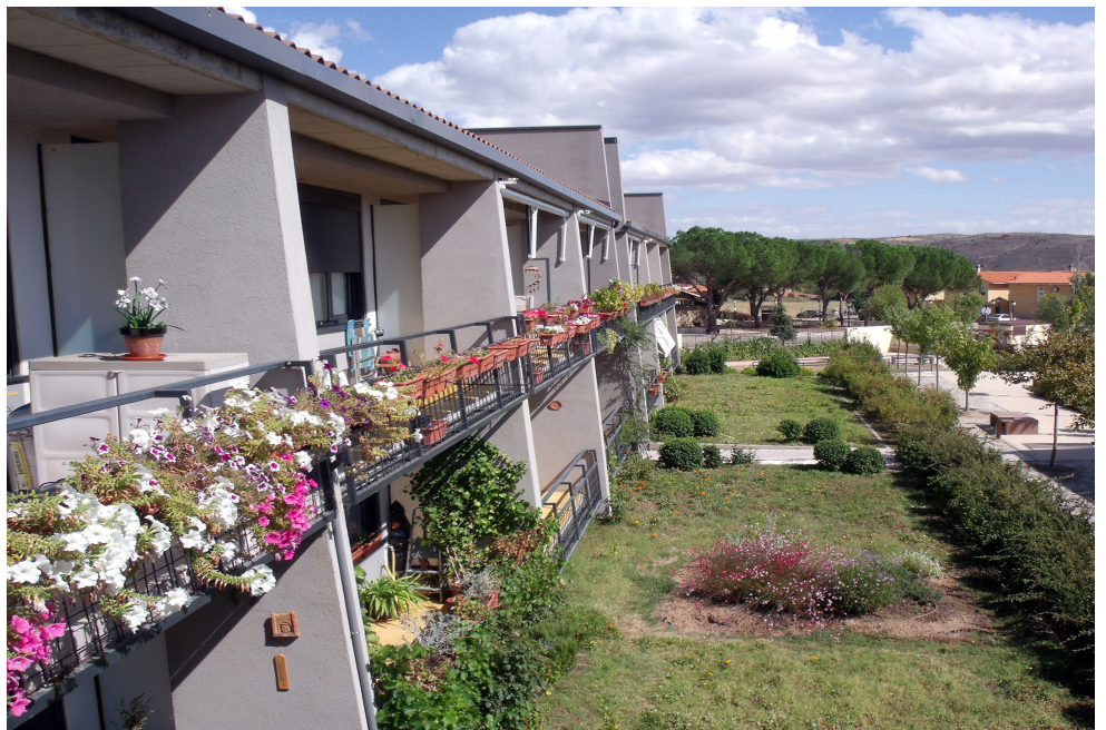
Fig 40. Terrazas exteriores de las unidades privadas. Trabensol.org. Fuente: https://trabensol.org/jardines/ (consultado el 25 de agosto de 2021)
