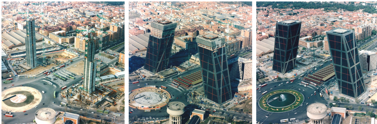
Fig 2.7. Seguimiento de obra de las torres KIO
