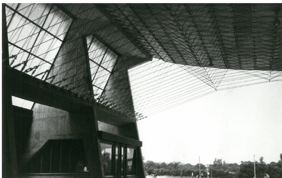
Fig 3.5. Estación de Servicio de los Enlaces, Zaragoza, 1961
