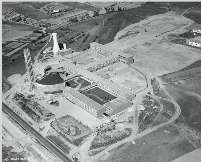
Fig C.1. Reportaje completo Convento y Teologado de los Padres Dominicos, en construcción, 1959
