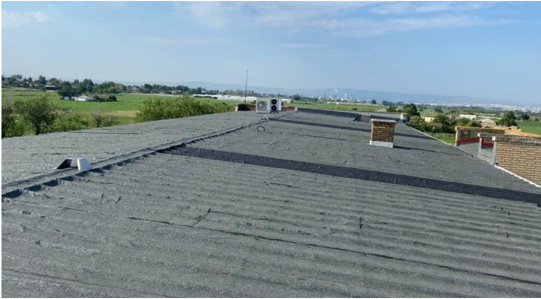
Imagen XIV- Cubierta del edificio
