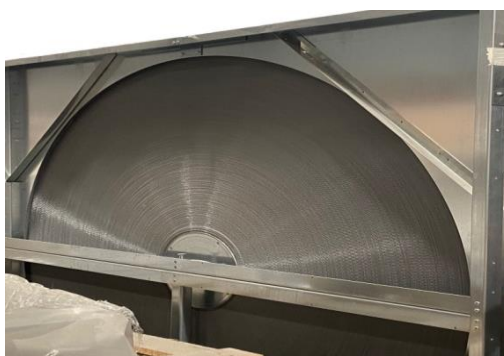
Figura 8: Recuperador rotativo. Fuente: Visita EVAIR
