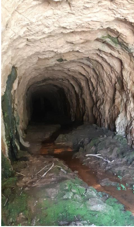
Figura 48. Antiguo desagüe que podría ser rehabilitado para facilitar el paso de sedimentos y fauna conectando así la longitudinalidad del cauce. Elaboración propia
