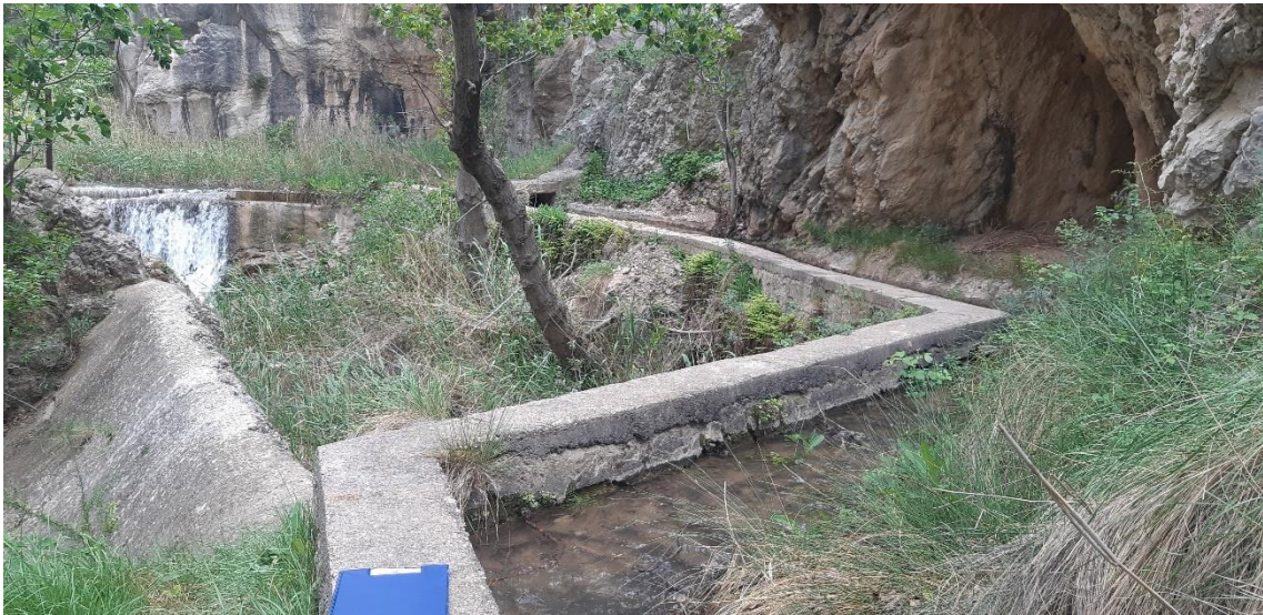
Figura 47. Azudes y canalización bajo el embalse que podrían ser desmantelados. Elaboración propia
