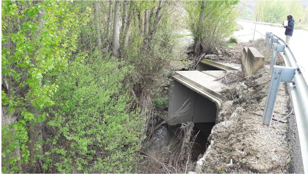
Figura 49. Puente sobre el río Escuriza con los prefabricados de hormigón. Fuente. Virginia Garófano
