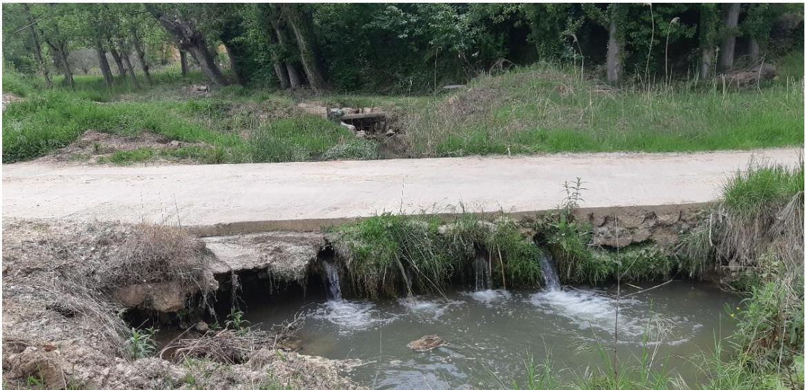
Figura 51. Vado que podría sustituirse por un pequeño puente. Elaboración propia
