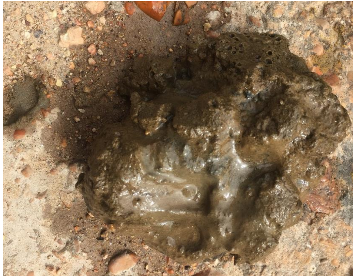
Figura 22. Sedimento cubierto por una pátina de finos. Elaboración propia
