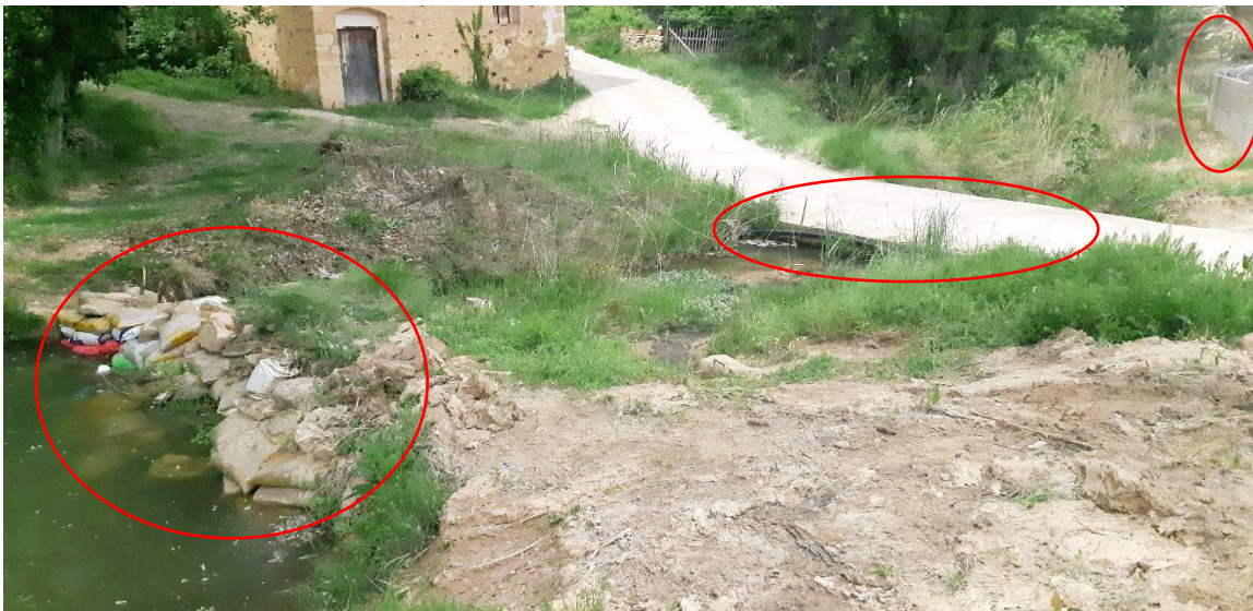
Figura 18. Obstáculos y construcciones en DPH. Elaboración propia
