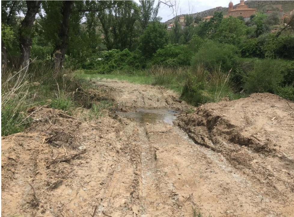
Figura 52. Vado propuesto para descompactarlo y cerrar definitivamente el camino. Fuente. Alfredo Ollero
