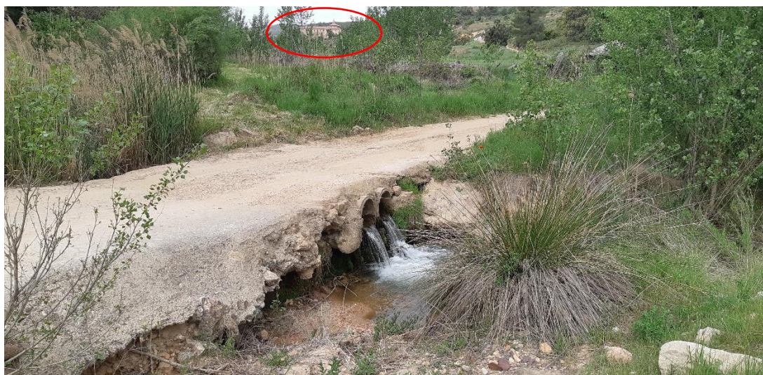
Figura 21. Vado permanente aguas abajo del monasterio. Elaboración propia
