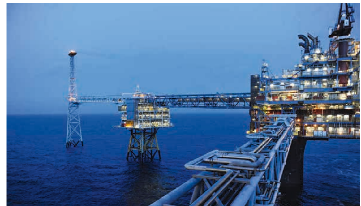
5.24 > Im Sleipner-Gasfeld in der Nordsee wird Kohlendioxid, das bei der Erdgasförderung mit zur Meeresoberfläche aufsteigt, direkt vor Ort aufgefangen, verflüssigt und im Anschluss 880 bis 1100 Meter tief im Meeresboden eingelagert.
