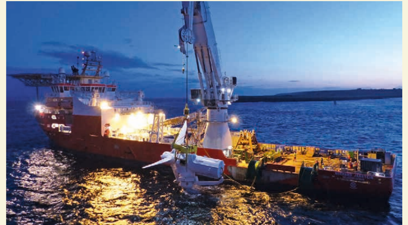
5.32 > Eine der schnellsten Meeresströmungen Schottlands treibt die Unterwasserrotoren des MeyGen-Strömungskraftwerkes an. In einer ersten Phase hat die Betreiberfirma vier Turbinen am Meeresboden installiert, die seit August 2018 rund 2600 Haushalte mit Strom versorgen. Weitere Turbinen sollen folgen.
