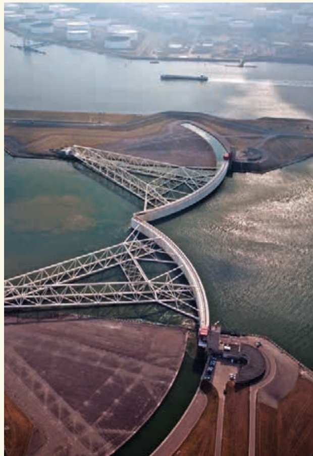
4.18 > Droht dem Großraum Rotterdam eine Sturmflut, schließen sich diese kreisbogenförmigen Tore des Maeslant-Sperrwerkes. Es schützt sowohl die Stadt als auch ihren Hafen vor Hochwasser.
