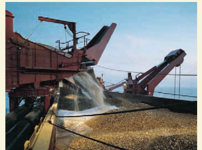
5.16 > Vor der niederländischen Insel Ameland fördert ein Saugbagger Sand vom Grund der Nordsee, mit dem der Inselstrand verbreitert werden soll.
