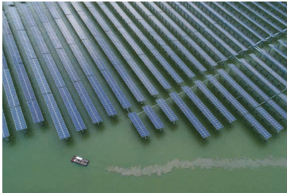
5.33 > Photovoltaikanlagen werden bislang vor allem in flachen, vor Wind und Wellen geschützten Meeresbuchten errichtet. Ein Beispiel ist diese Anlage in der chinesischen Küstenstadt Zhangzhou.
