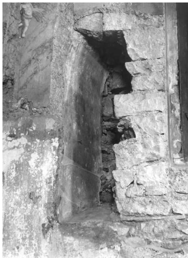
17. kép. A hajó ÉK-i falán a falkutatás során feltárt, befalazott ablaknyílás (Mihalik Tamás felvétele)
