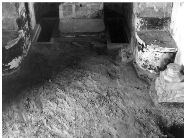
22. kép. A padozat alatt feltárt sziklafelszín és a középkori habarccspadló a hajó szentély felőli részén (Mihalik Tamás felvétele)
