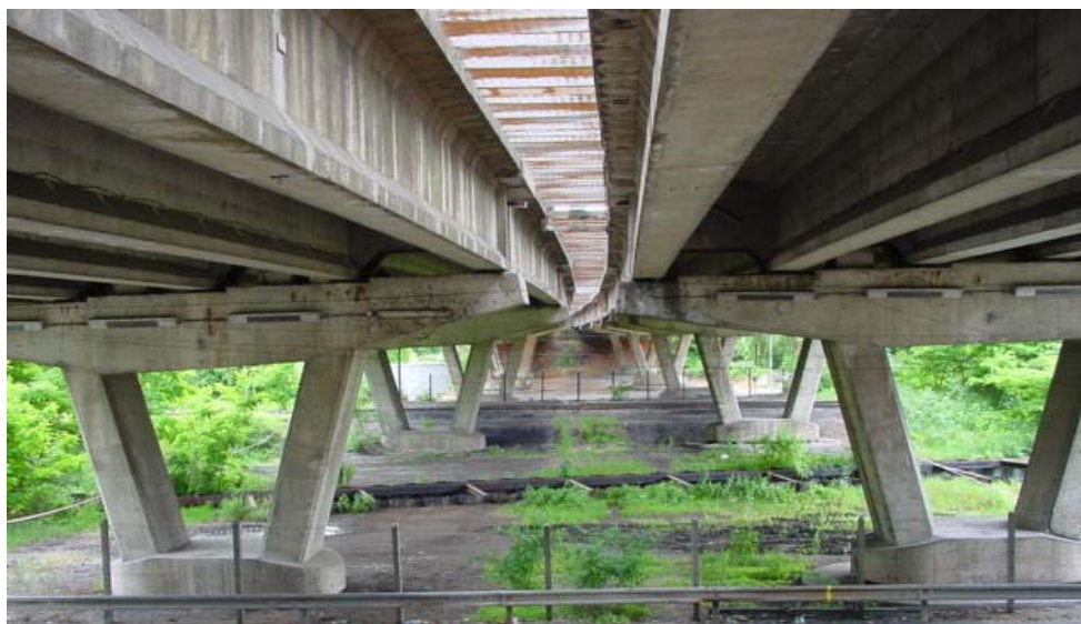
Figure 3.18. Vue générale du viaduc de Merlebach
