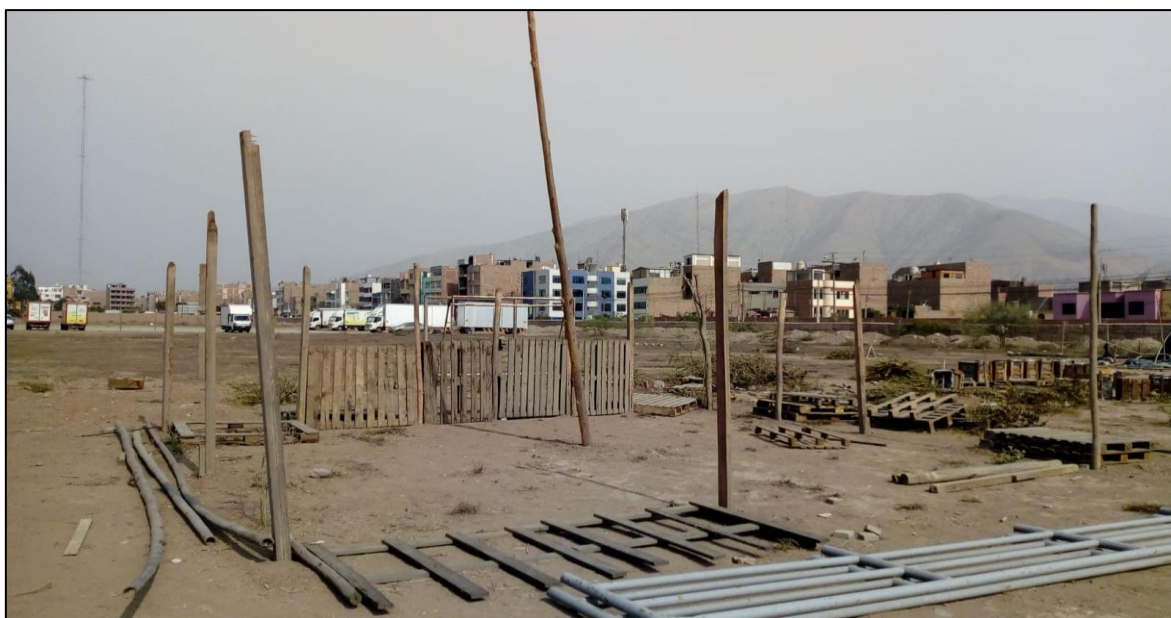
Figura 22. Estado inicial del área de ejecución del proyecto.
