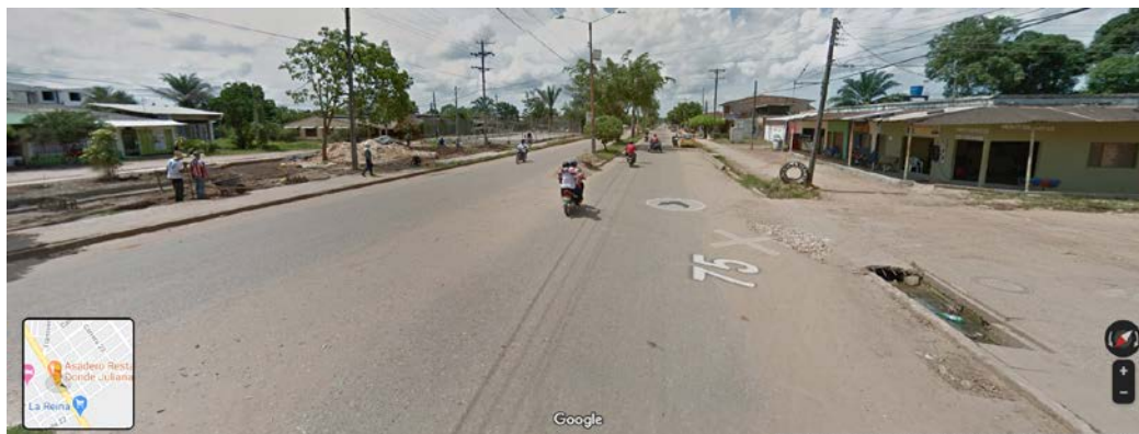
Figura 4-11: Tramo vial en pavimento flexible, carrera 20 con calle 19.
