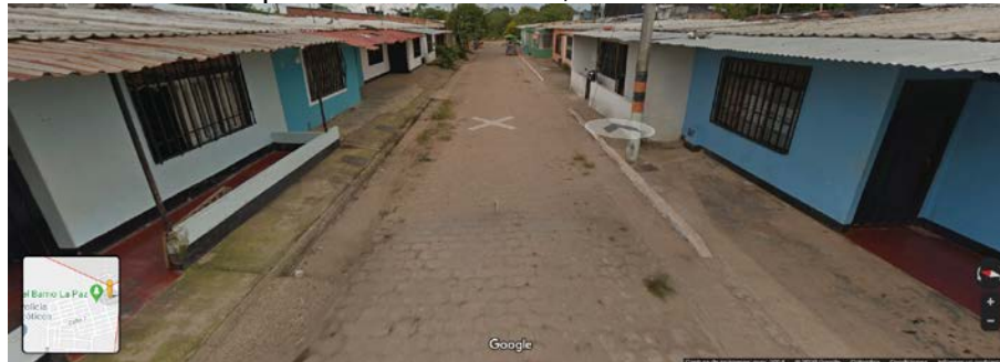
Figura 4-13: Tramo vial en pavimento articulado, calle 6a con carrera 30.
