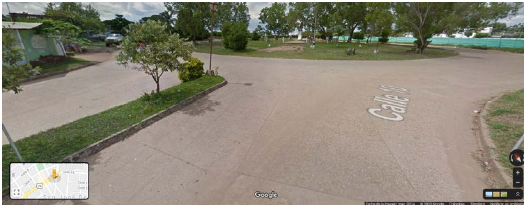
Figura 4-10: Tramo vial en pavimento rígido, calle 10 con transversal 20.
