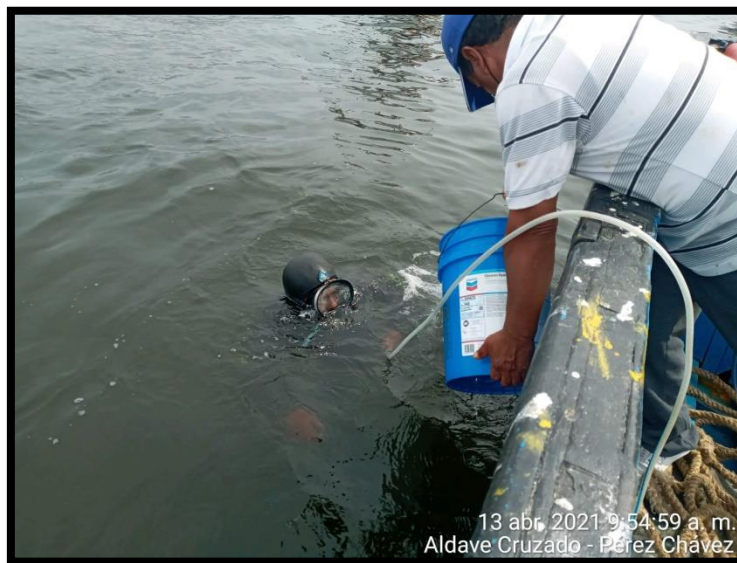
Figura 4. Retiro del lodo orgánico con la ayuda de un balde
