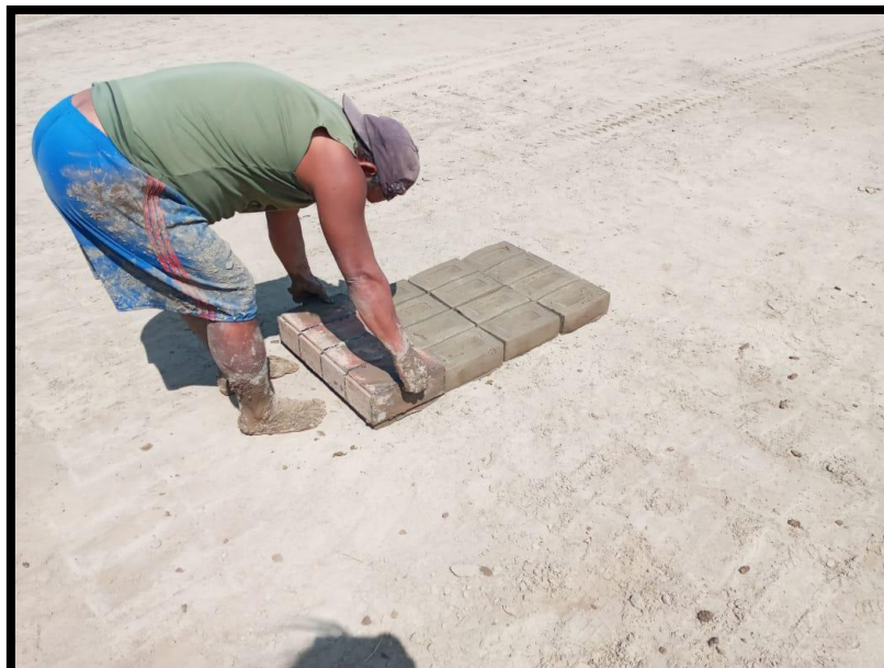
Figura 28. Se retira la arcilla del molde
