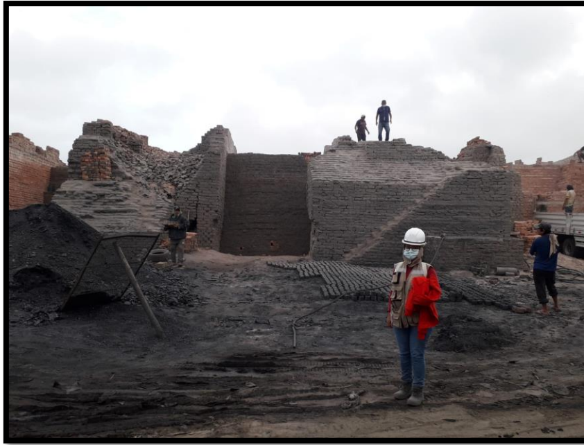
Figura 37. Horno habilitado para su colocación de las muestras.
