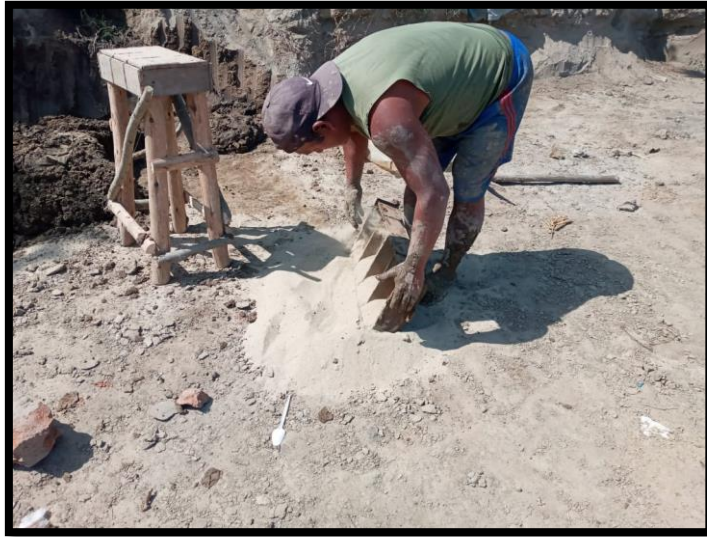
Figura 25. Se embarro al molde con arena gruesa para evitar que se pegue el lodo al retirar del molde.
