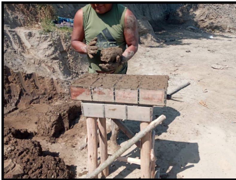
Figura 26. Colocación del lodo en el molde
