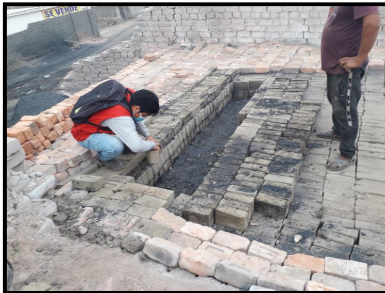
Figura 38. Colocación de las muestras al horno
