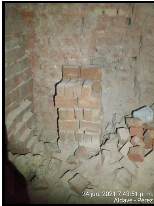
Figura 41. Muestra del ladrillo fuera del horno
