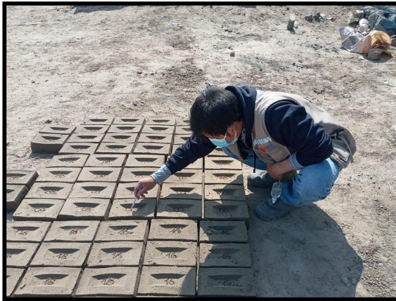
Figura 29. Se verifica la cantidad de los ladrillos
