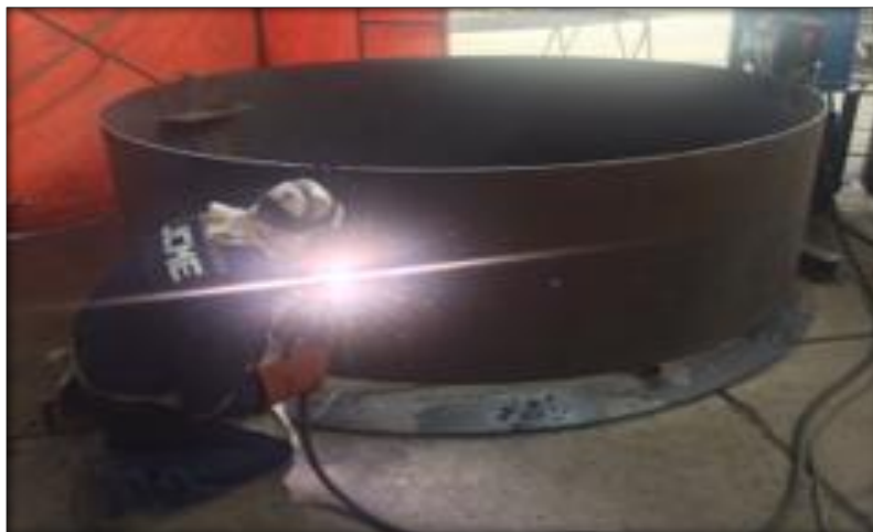
Figura 16. Proceso de soldadura
