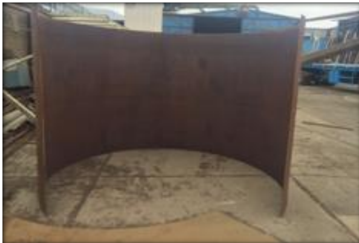
Figura 14: Doblez y rolado de planchas
