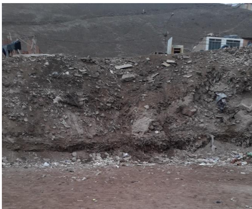
Imagen de la ubicación de la Calicata N° 02
