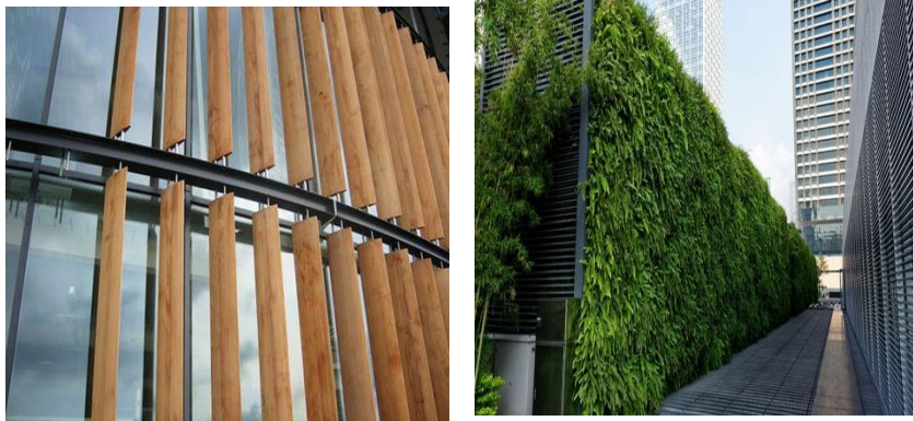
Figura N°39: Imágenes de parasoles y muro verde
