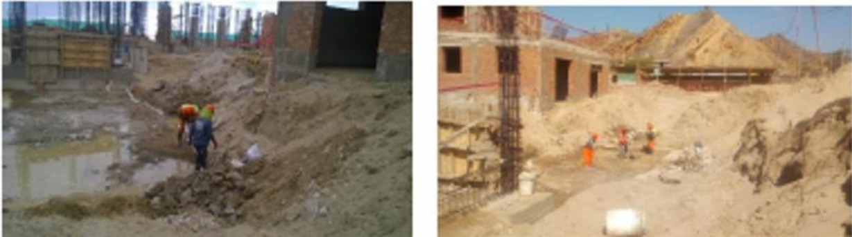
Figura 3. Cisterna de osmosis
