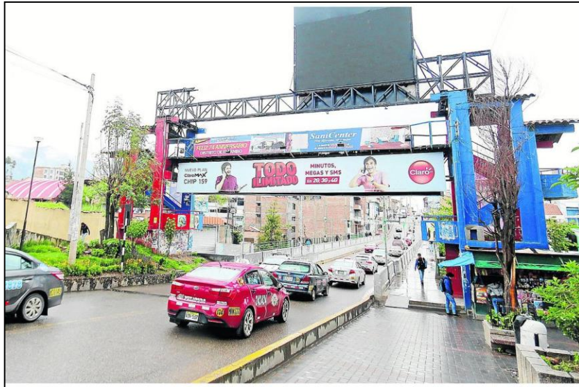
Figura 46. Puente peatonal “Bajada de El Tambo” - Huancayo
