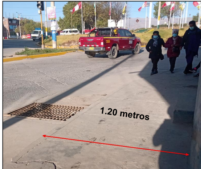
Figura 29. Ancho efectivo de 1.20 metros en jirón Julio Sumar
