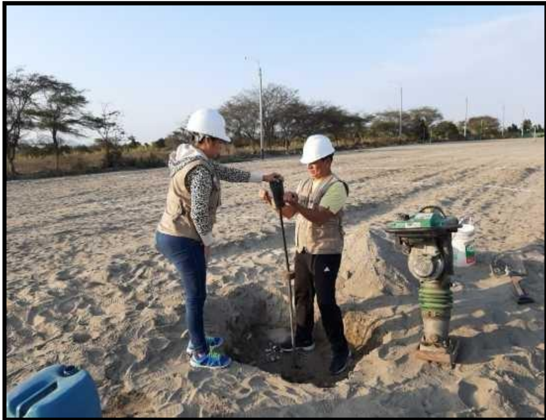
Ensayo de penetración dinámica ligera con material estabilizado, realizada por los tesistas Medaly Zavaleta Benites y Gustavo Aponte Sanchez
