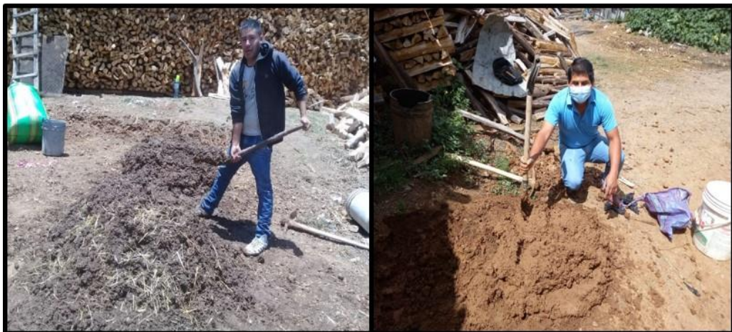
Gráfico 14 Se muestra el amasado del barro y se deja reposar 24 horas
