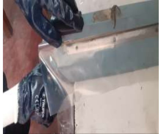
Figura 93. Trabajador usa EPP para trabajo en selladora, también se utiliza para trabajo con pistola de calor
