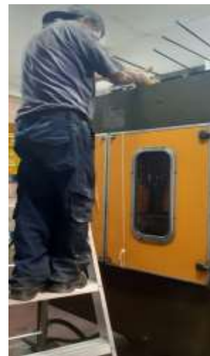
Figura 87. Trabajador al usar escalera no necesita empinarse.
