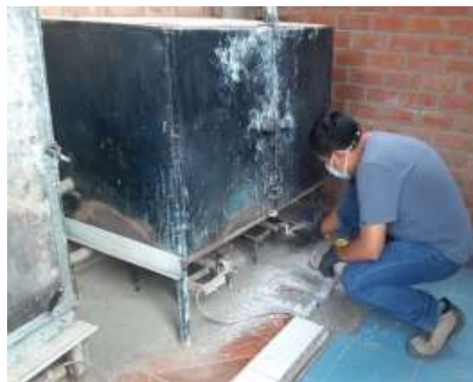
Figura 64. Trabajador utiliza EPP para minimizar el riesgo de quemaduras en manos pero su rostro está muy cercano al horno
