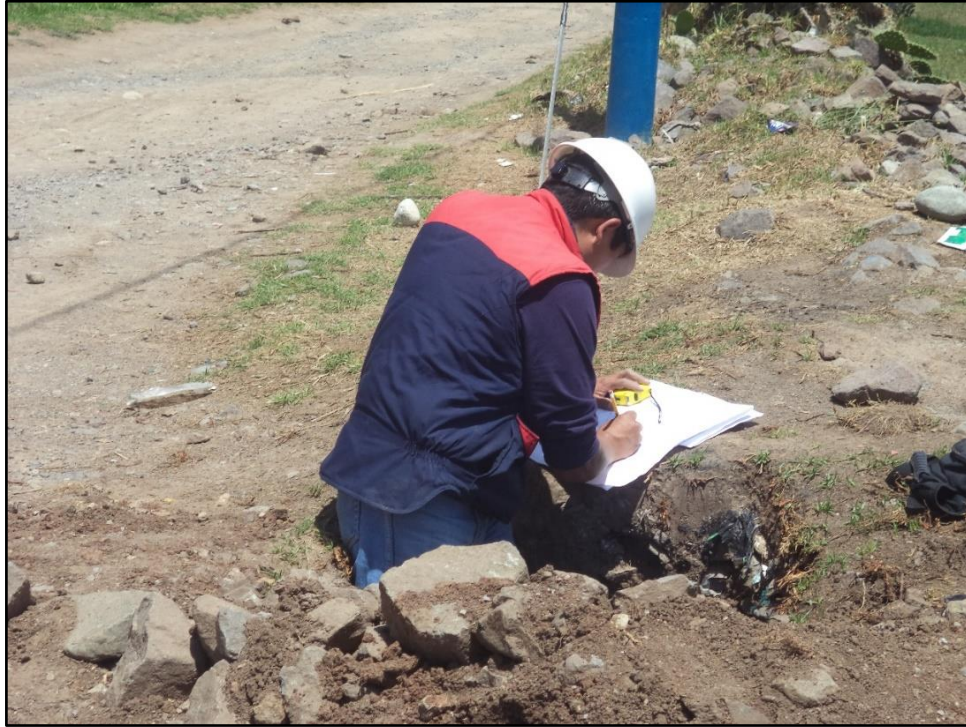
Fotografía 16. Se muestra la Calicata N°7 de la zona.
