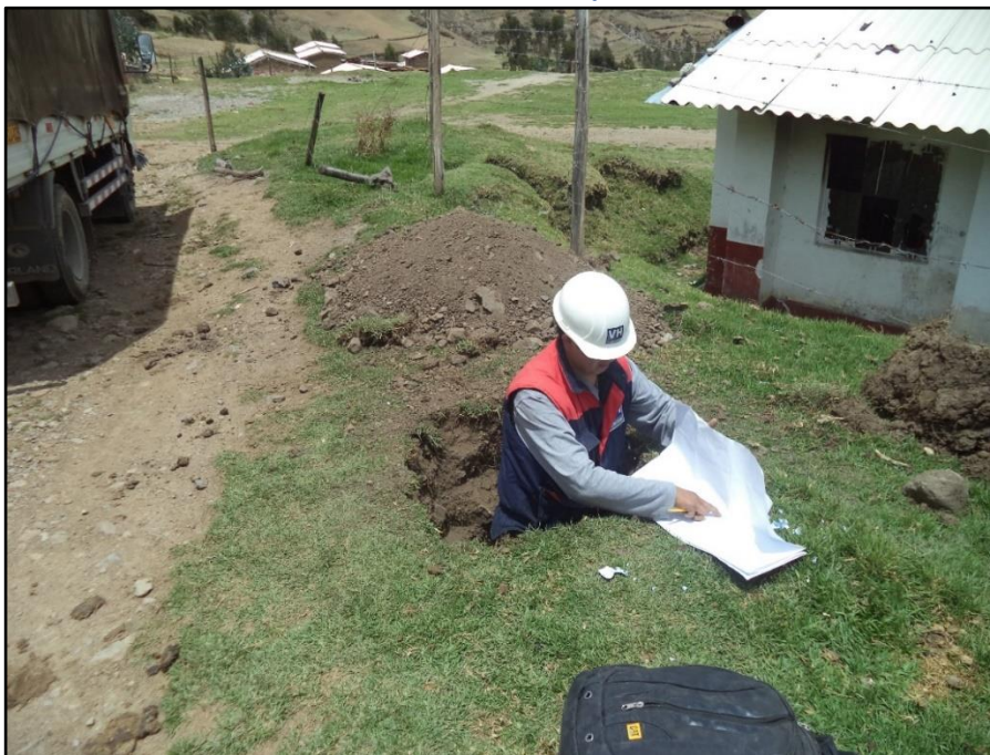
Fotografía 15. Se muestra la Calicata N°6 donde el tesista está realizando el reconocimiento correspondiente.
