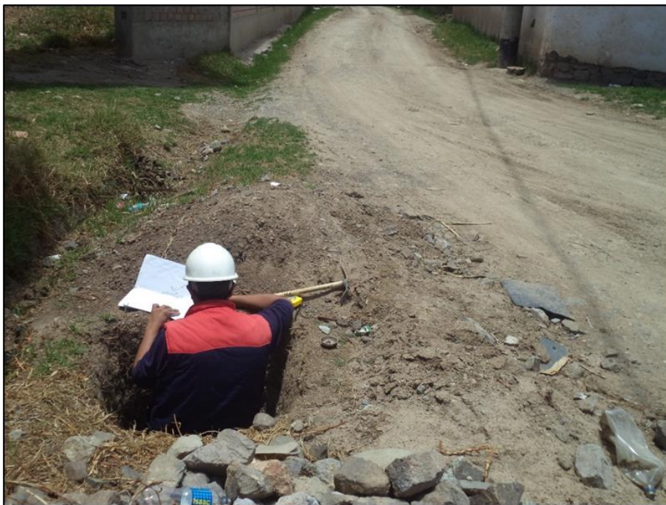
Fotografía 13. Se muestra la Calicata N°4, el cual se encontraba adyacente a la carretera de la zona estudiada.
