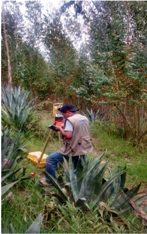
Fotografía 8. Levantamiento topográfico en los caminos de herradura existente de la zona en estudio.
