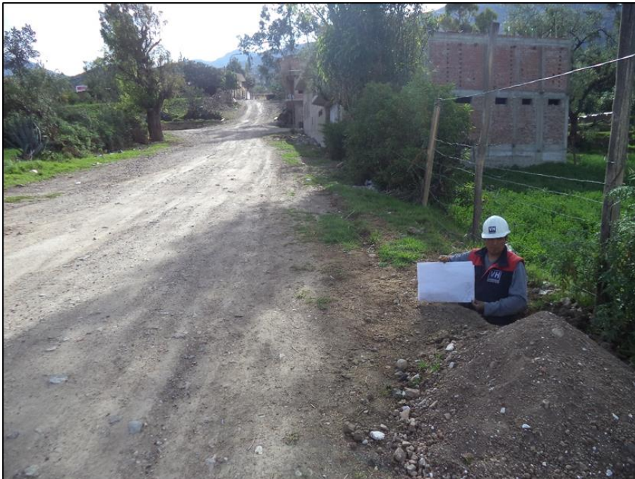
Fotografía 11. Calicata N°2 exploración a cielo abierto junto a la carretera de la zona estudiada.
