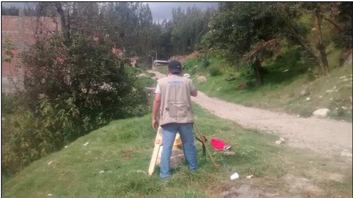
Fotografía 9. Levantamiento topográfico en la carretera existente de la zona en estudio.
