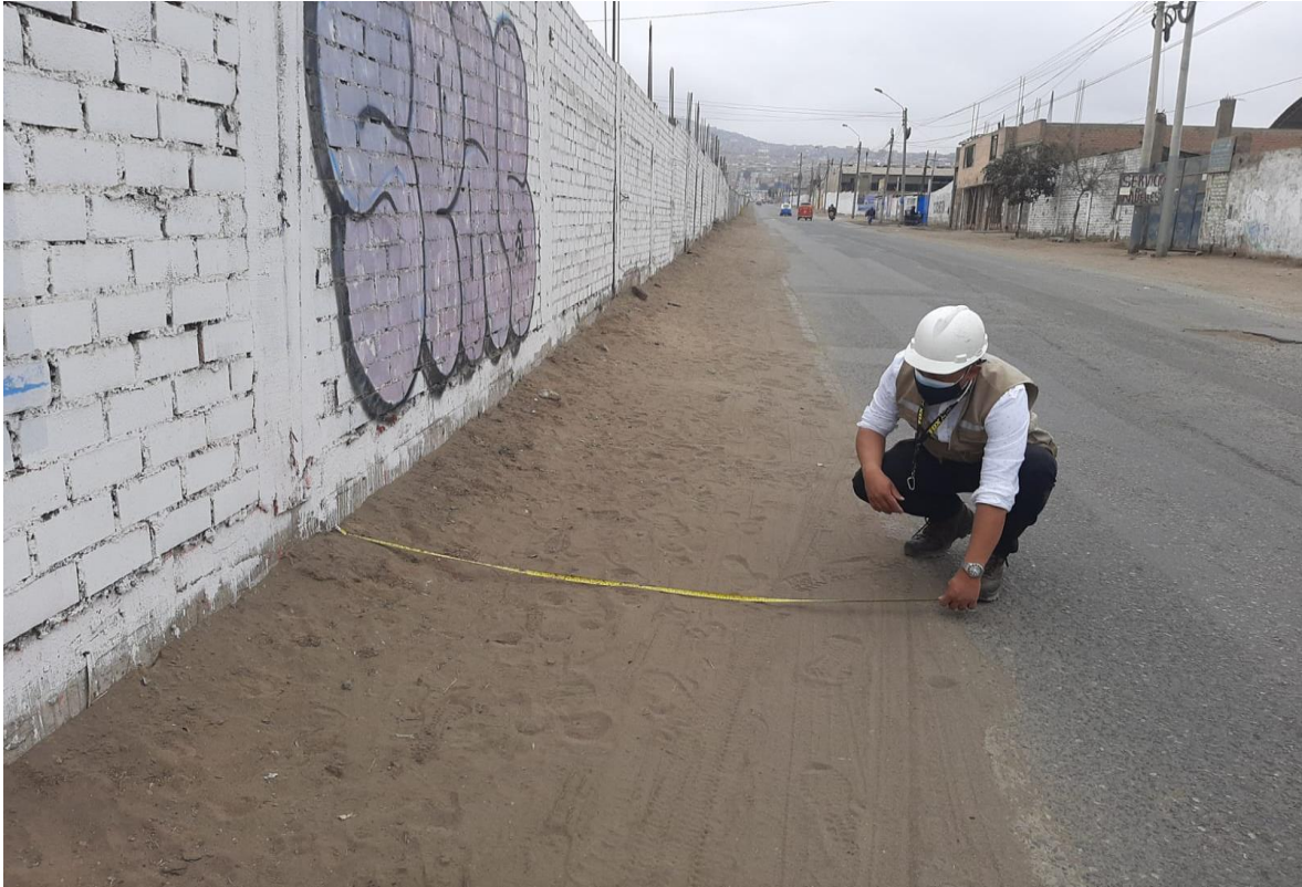
Medición de berma lateral izquierda
