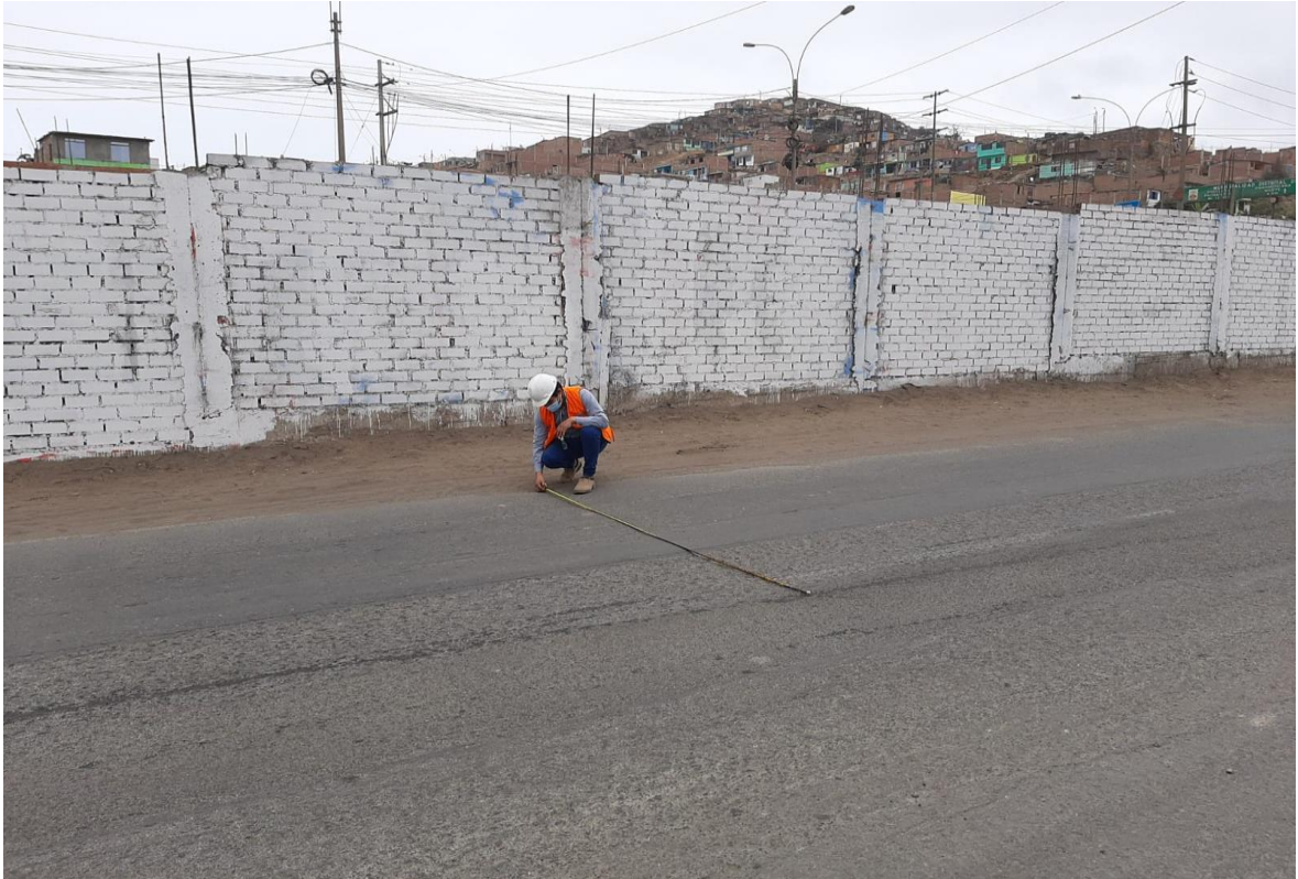
Medición de la calzada
