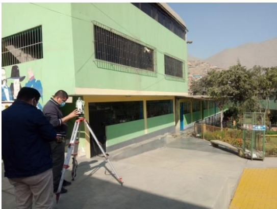
Iniciando el levantamiento topográfico
