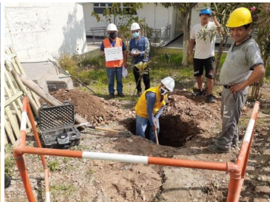
Excavación de calicata C-2 M-1
