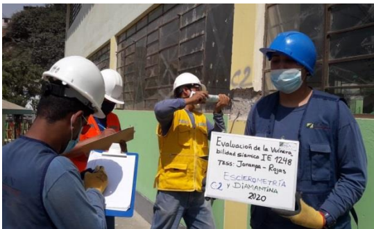
Ensayo de Esclerometría
