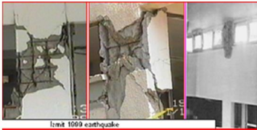
Fig. 23 Varias fallas de columnas cortas observadas después de terremotos. Fuente (Isik G., 2006).
