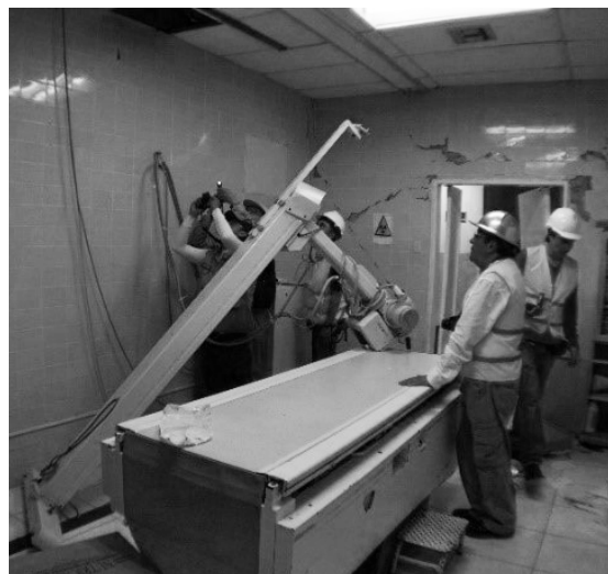
Foto 2. Hospital IESS de Manta internamente. Fuente: autores
