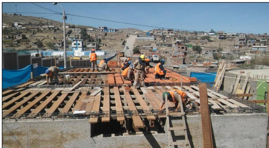
*Figura 6.* Se observa trabajos de encofrado en la Obra: Portales de Chiguata
