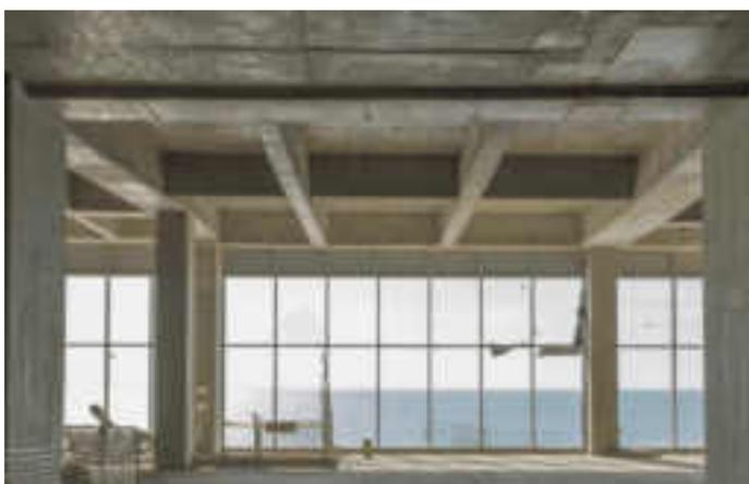
*Figura 53.* Losa de concreto armado
