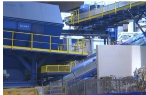
Figura N° 69: Ductos de tratamiento Fuente: Bizkaia
