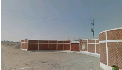
Figura N° 15: Vista Hospital San Ramón Fuente: Visita a campo
