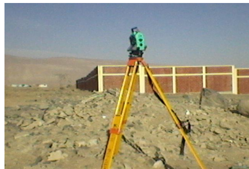
Figura N° 08: Trabajo topográfico Fuente: Gobierno Regional – UF
