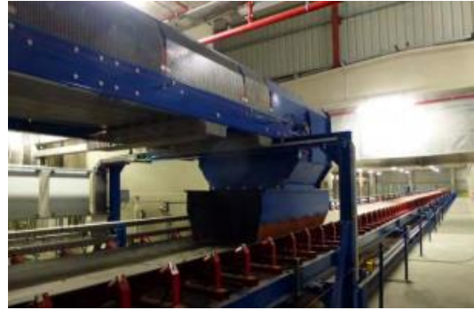
Figura N° 65: Sala de Maquinas Fuente: Bizkaia
