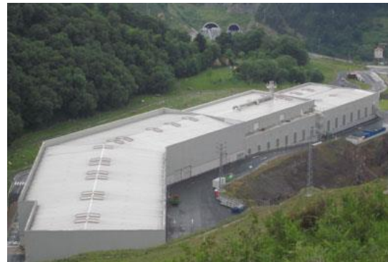
Figura N° 63: Vista aérea PTRSU TMB Fuente: Bizkaia
