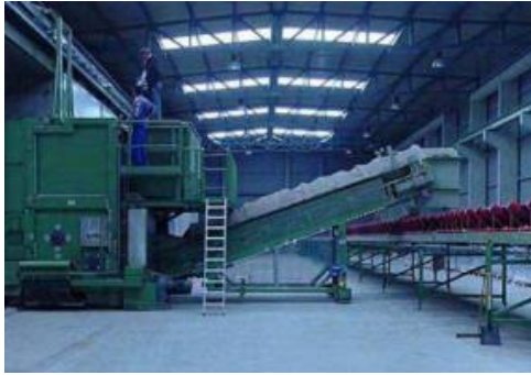
Figura N° 64: Sala de Máquinas Fuente: Bizkaia
