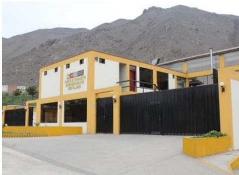
Figura N° 16: Planta de Tratamiento RSH Fuente: Hospital Hipólito U. – Lima Elaboracion: Cimelco
