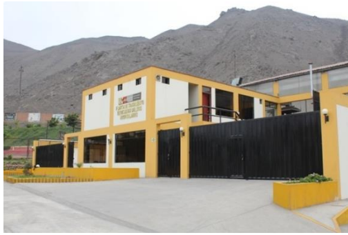
Figura N° 25: Ingreso Vehicular interno Fuente: Hospital Hipólito U. – Lima
