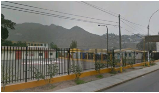
Figura N° 14: Cerco Perimétrico HHU Fuente: Hospital Hipólito U. – Lima Elaboracion: Cimelco
