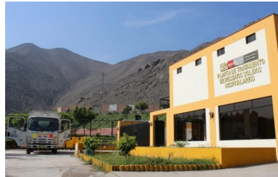
Figura N° 26: Ingreso peatonal interno Fuente: Hospital Hipólito U. – Lima
