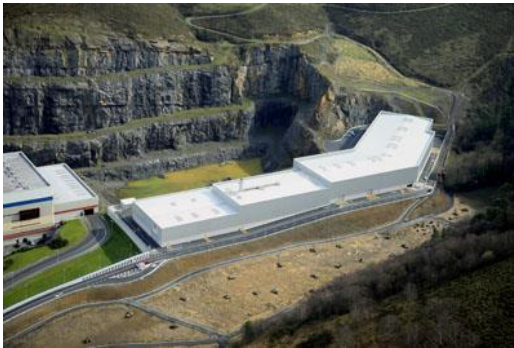
Figura N° 60: Vista aérea PTRSU TMB Fuente: Bizkaia
